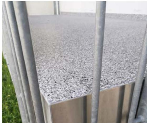
Sikafloor® Böden bestehen aus drei Schichten: dem Untergrund, der Zwischenschicht und der Nutzschicht.
