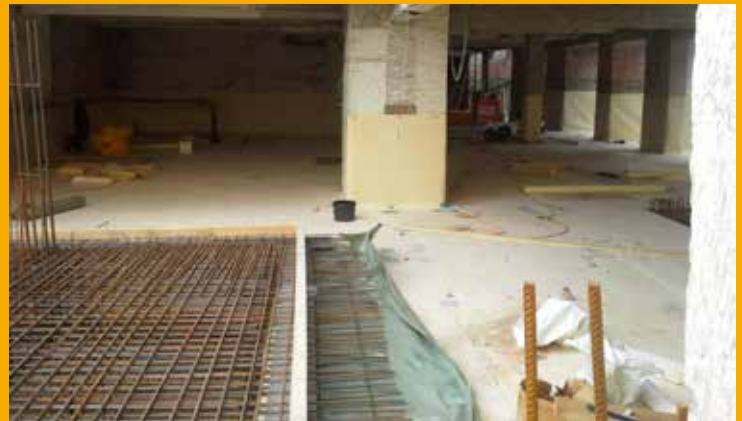
Die Sanierung des Tiefgeschosses erfolgte durch Ausbildung einer neuen Innenwanne mit dem Frischbetonverbundsystem SikaProof® A. Die Bestandswände wurden mit einer nachträglichen Horizontalsperre gegen aufsteigende Feuchtigkeit gesichert.
