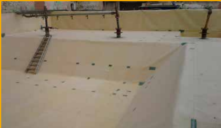
Das Frischbetonverbundsystem SikaProof® A der Sika Deutschland GmbH. Die hochflexible und rissüberbrückende FPO-Bahn stellt einen dauerhaften Verbund mit dem erhärtenden Frischbeton her.
