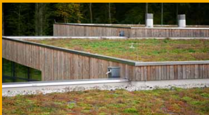
Die extensive Dachbegrünung dient als Auflast auf der lose verlegten Sarnafil-Dachbahn.
