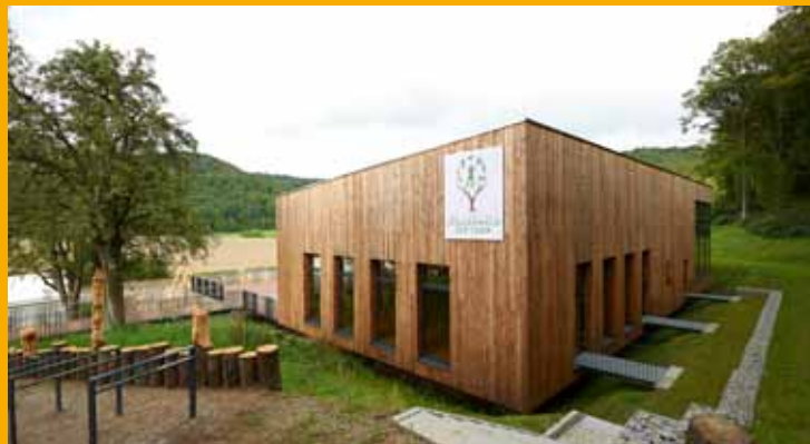
Das gesamte Gebäude wurde in Holzbauweise aus unterschiedlichen, teilweise heimischen Holzarten errichtet.
