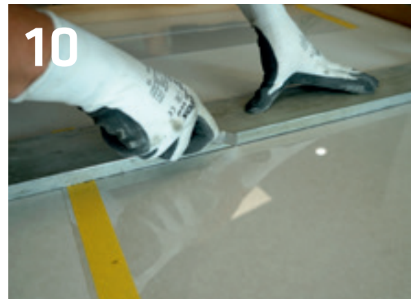
Der Zuschnitt der Schalungsfolien erfolgt mit einem Cuttermesser. Die Folien sind mehrfach nutzbar und können mit Wasser gereinigt werden.
