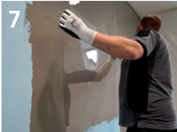
Die Folie wird eingelegt.
