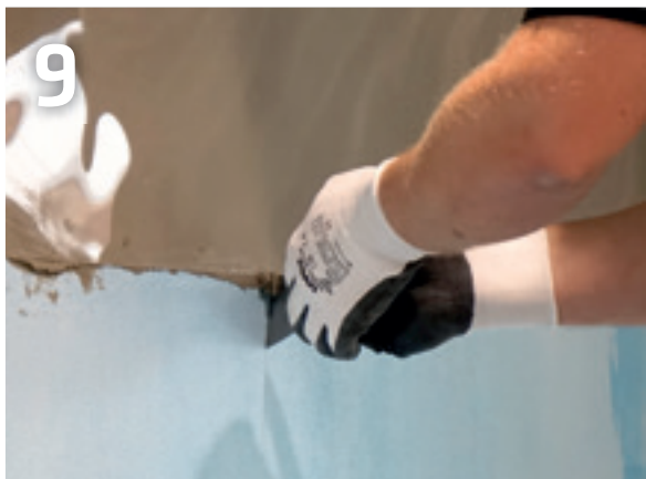
Das ausgetretene Material abtragen.
