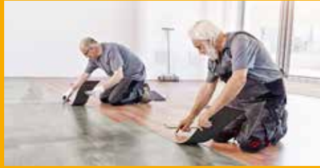
FLIESEN-, WAND- UND FUSSBODENTECHNIK
