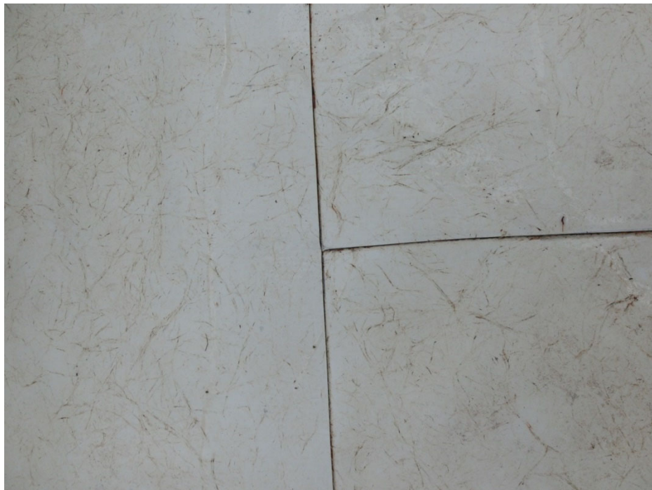
Abb. 4: Detailaufnahme T-Naht des Prüfkörpers am Testende
