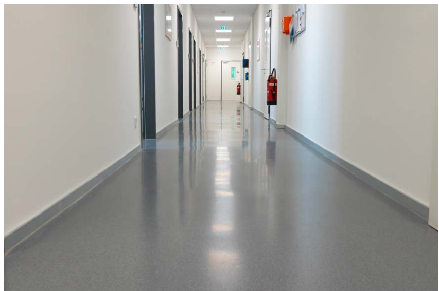
Fertig appliziertes Beschichtungssystem: Sikafloor® DecoDur ES-22 Granite.
