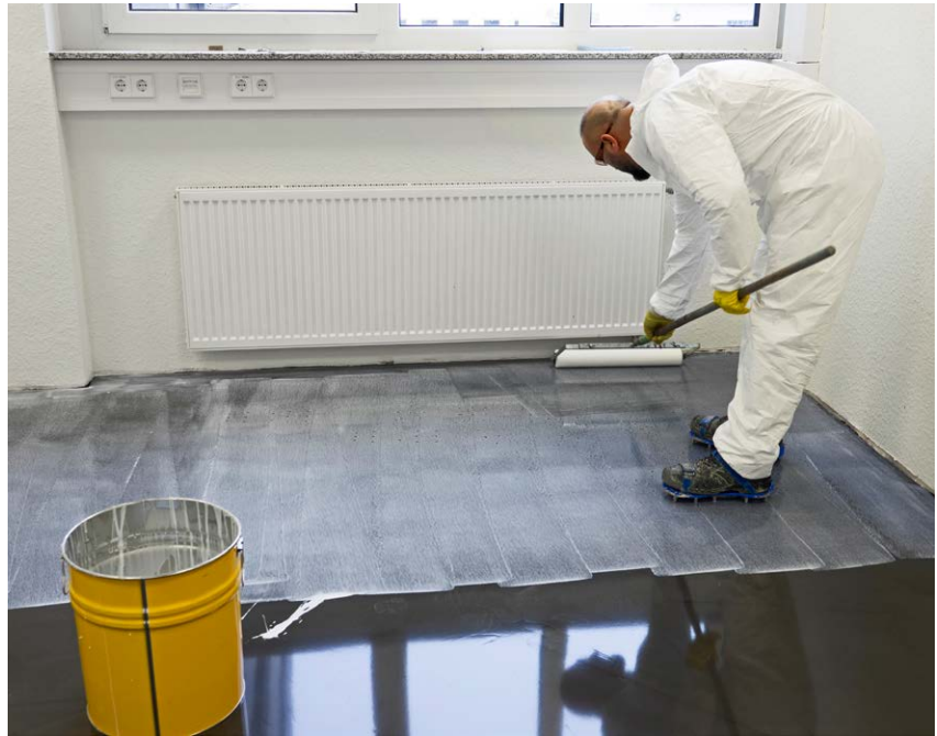
Die Versiegelung Sikafloor®-304 W wird mit einer Walze gleichmäßig verteilt.
