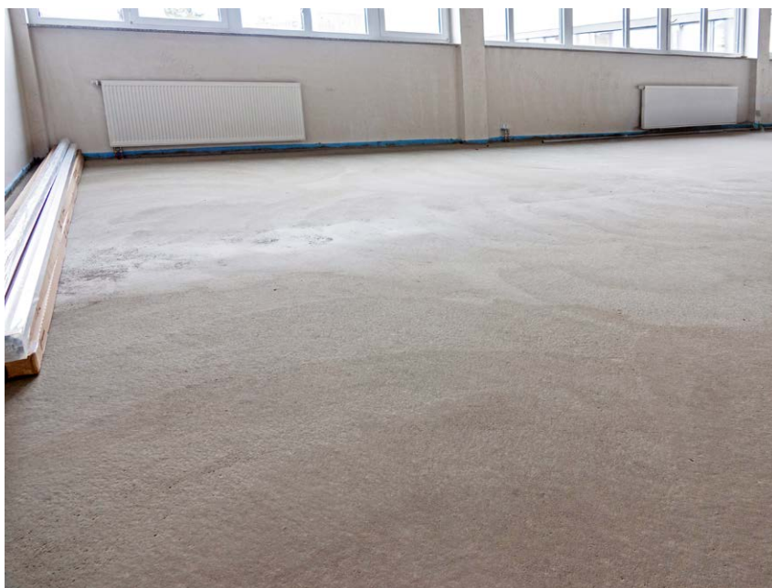
Der trockene Estrich nach der Aushärtezeit.
