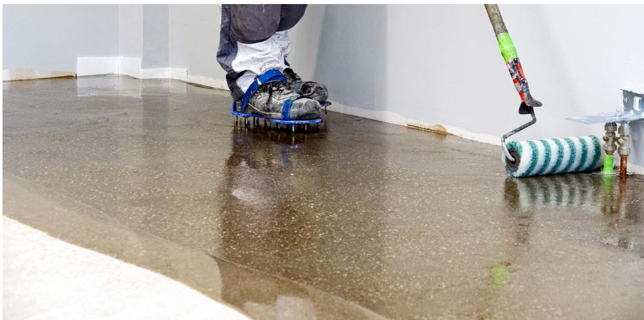
Die Grundierung Sikafloor®-150 wird mit einer Gummirakel aufgetragen und mit einer Walze nachgerollt.
