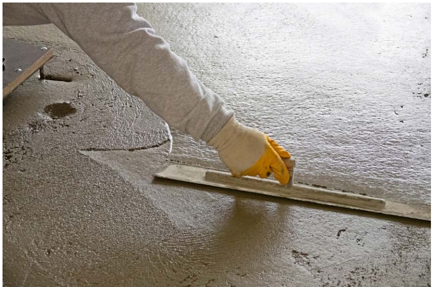
Ausgleich von Feinheiten mit dem Glättschwert.
