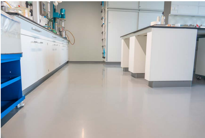
Fertig appliziertes Beschichtungssystem Sikafloor® MultiFlex PS-32 UV.
