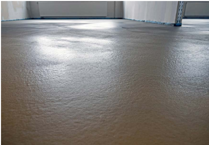
Der frisch eingebaute und noch feuchte Estrich.
