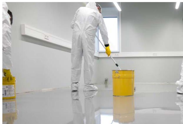
Walzen der Versiegelung Sikafloor®-305 W.
