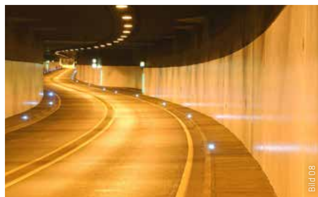
Auch ein zweiter Stuttgarter Tunnel, der B295-Tunnel in Stuttgart-Feuerbach, erhielt zur selben Zeit eine Wandbeschichtung mit Sikagard®-260 WPU.
