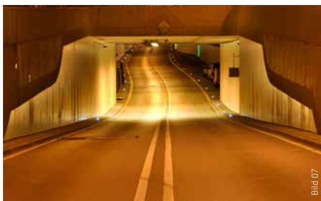
Das in den 1980er Jahren errichtete Tunnelbauwerk erhielt eine sicherheitstechnische Nachrüstung mit Beleuchtungs-, Brandschutz- und Lautsprecheranlagen sowie eine neue Tunnelwandbeschichtung.
