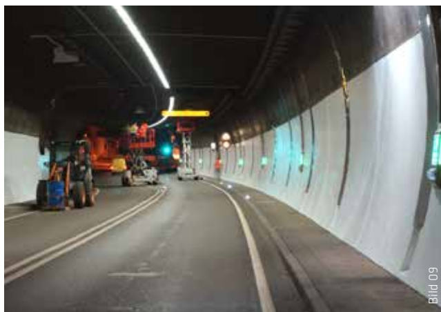
Die Sika Deutschland GmbH entwickelte das eingesetzte Oberflächenschutzsystem – die wässrige 2-K-Polyurethanbeschichtung Sikagard®-260 WPU. Sie durchlief erfolgreich alle erforderlichen Prüfungen nach OS 4 und vorgeschriebenem Brandschutz und wurde in die BASt-Liste aufgenommen.
