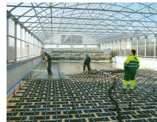
Höhere Verlegegeschwindigkeiten sind möglich
