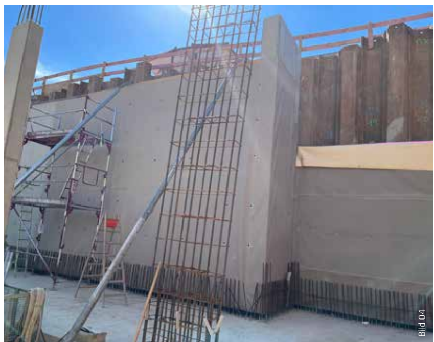
Verlegung der SikaProof® A+ in einhäutig wie auch zweihäutig geschalteten Wandbereichen.
