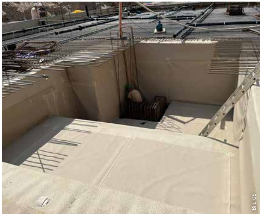
Auch in geometrisch anspruchsvollen Bereichen ist eine fachgerechte und saubere Installation von SikaProof® A+ möglich.
