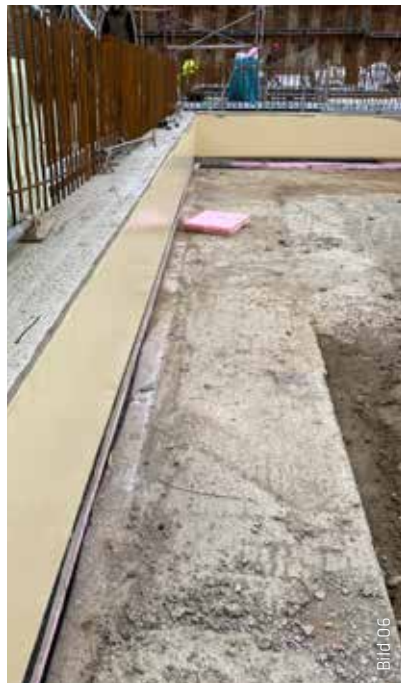
SikaProof® in der Bodenplattenstirnseite. In zweihäufig geschalteten Bereichen wurde SikaProof® A+ im Fugenbereich ausgespart und später mit dem Sikadur-Combiflex® TF System abgedichtet.
