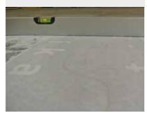
Vor dem Schleifen muss der Epoxidharzkleber komplett ausgehärtet sein. Mittels Diamanttopfscheibe wird ein höhengleicher Übergang zwischen den Betonplatten hergestellt.
