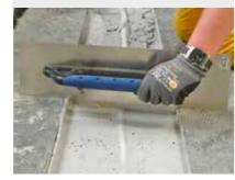
Im nächsten Schritt wird der Systemkleber gleichmäßig aufgebracht. Hierfür eignet sich besonders der höhenverstellbare Sika® FloorJoint Verlegespachtel.
