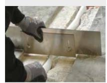
Nachdem vorbereiten und Aussparen der Fuge folgt der Einbau des Randdämmstreifens in U-form oder als Rundschnur.
