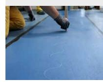
Am Folgetag können die Dehnfugenpaneele mit einer Sikafloor® Industrie- bzw. Parkhausbeschichtung beschichtet werden.
