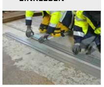
Nach dem gleichmäßigen Aufbringen des Systemklebers werden die Paneele passgenau eingeklebt.
