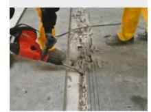
Das schadhafte Profil ausbauen oder Aussparung herstellen und Untergrund durch schleifen sowie absaugen vorbereiten.
