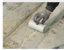
Anschließend wird der Dichtstreifen unterhalb des Dehnfugenprofils aufgebracht.
