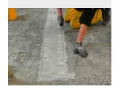
Das Profil wird passgenau eingelegt und verklebt. Lufteinschlüsse zwischen Paneel und Kleber müssen vermieden werden. Anschließend werden die Fugen verspachtelt.
