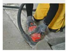
Das schadhafte Profil ausbauen oder Aussparung herstellen und Untergrund durch schleifen sowie absaugen vorbereiten.
