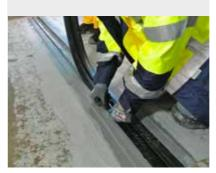
Am Folgetag wird die Gummieinlage nach Aktivierung und Reinigung zugeschnitten und eingeklebt, das wird Fugenprofil anschließend eben abgeschliffen.
