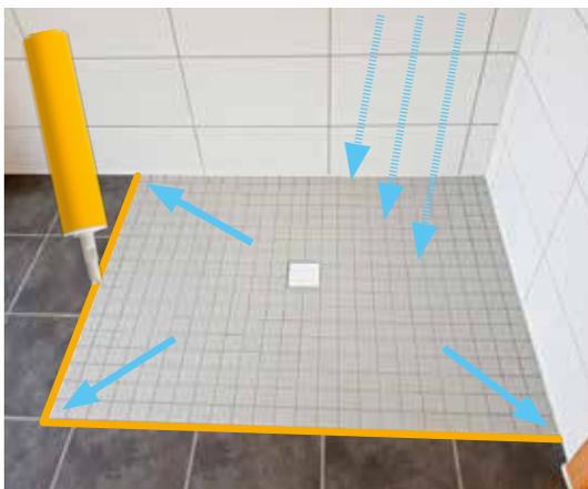
Die Einarbeitung der Sperre erfolgt frisch in frisch im Zuge der Fliesenverlegung. Der Querschnitt der Dichtstoffraupe ist an die Fliesen und Plattendicke anzupassen und sollte nicht durch die Fliesenfuge durchdrücken.
