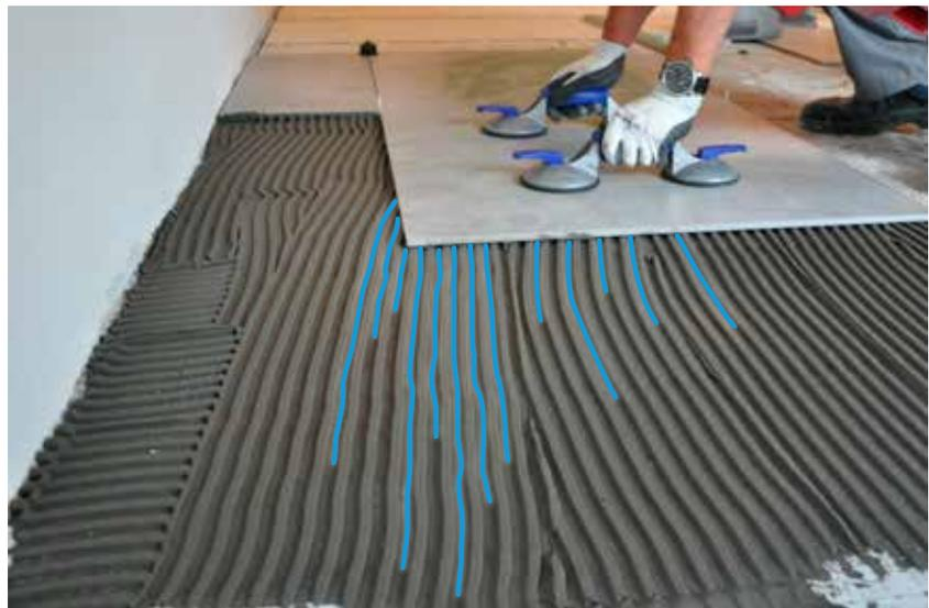
Kleberkanäle durch Zahnkamm bei einseitigem Kleberauftrag (Floating-Verfahren)
