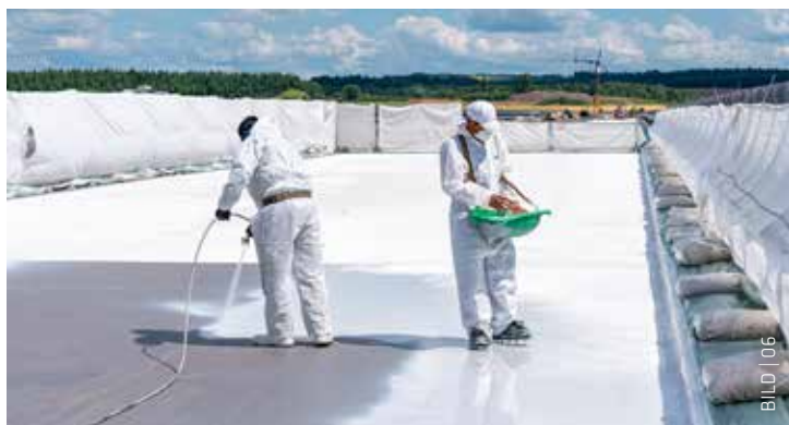
Zur Abdichtung der Fahrbahn wurde Sikalastic®-827 HT als Klebeschicht eingestreut. Zuvor waren SikaCor® HM Primer als Grundbeschichtung und SikaCor® HM Mastic als Haftschrift appliziert worden.
