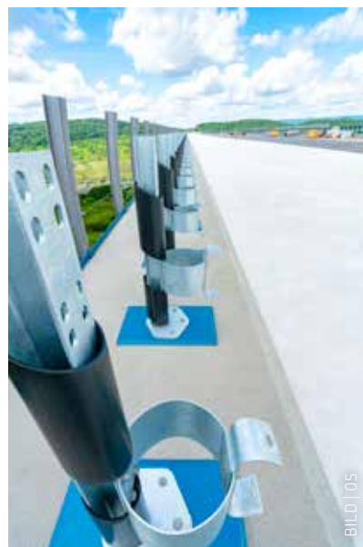
< Der Gehwegbereich erhielt einen Beschichtungsaufbau gemäß ZTV-ING, Teil 7, Abschnitt 5 (RHD-ST Beläge).
