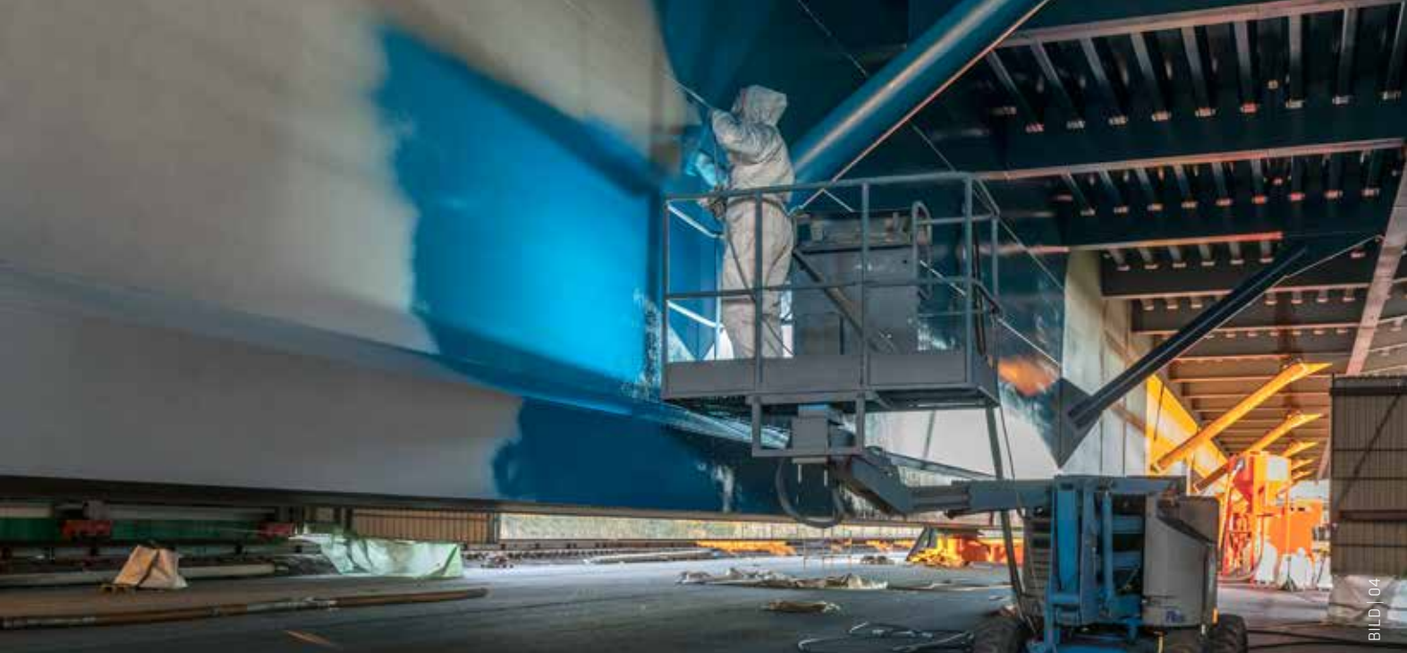
Applikation der eisenglimmerhaltigen Deckbeschichtung SikaCor® EG-4. Die Verarbeitung erfolgte in der eigens entwickelten mobilen Korrosionsschutzhalle in zeitlicher Taktung mit dem Verschieben der sukzessiv montierten Bauteilgruppen.
