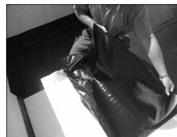
Bahnenende nach Abziehen der Trennfolie auf Untergrund fixieren
