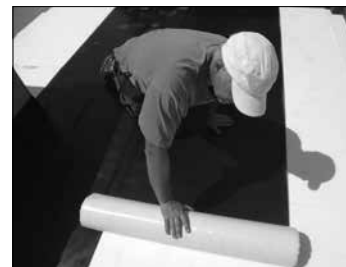
Ausrollen und Ausrichten der Dachbahn
