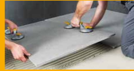
FLIESEN-, WAND- UND FUSSBODENTECHNIK
