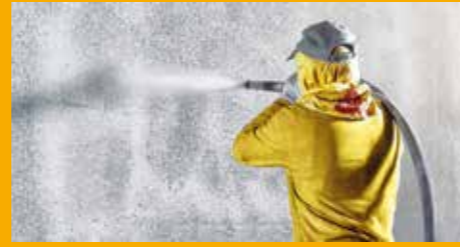
BETONSCHUTZ UND INSTANDHALTUNG
