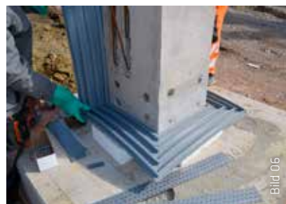
Einlegen des Sikadur-Combiflex® TF Fugenbandes in das frische Klebebett und Montage der Lochblechschienen als Fixierhilfe.
