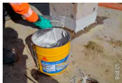
Grundauftrag des Sikadur-Combiflex® CF Klebers als erster Arbeitsschritt der Montage.
