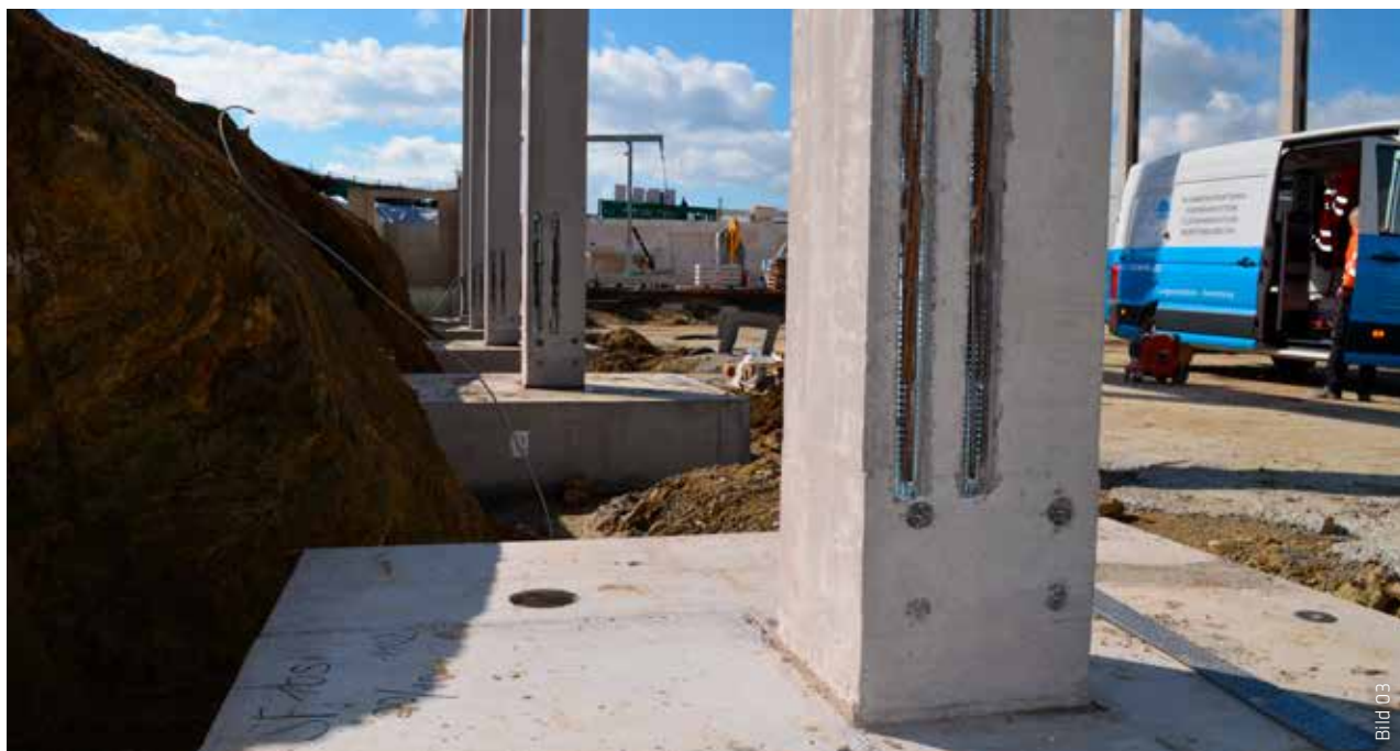
Diese Fertigteilstützen mit Einzelfundamenten durchdringen die spätere Ortbetonbodenplatte. Um die Anschlussfugen der Bodenplatte an die Stützen mit dem Sikadur-Combiflex® TF System abdichten zu können, muss der Betonuntergrund zur Vorbereitung angeschliffen und entstaubt werden.
