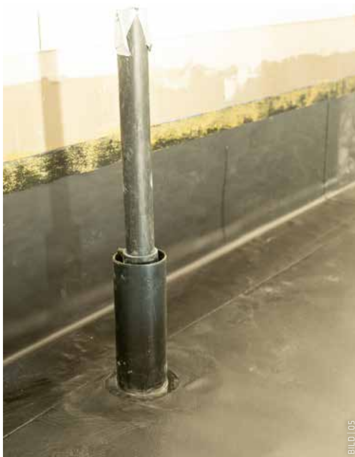
Systemformteile, die mit der Kunststoffbahn verschweißt wurden, ermöglichten die zuverlässige Abdichtung von Detailanschlüssen.
