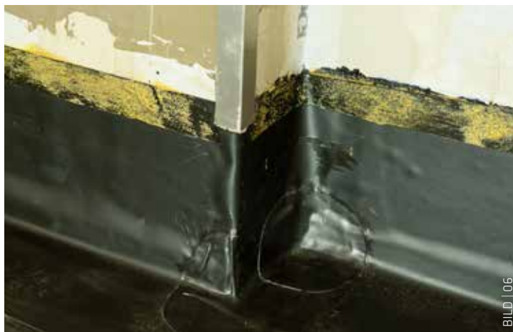
Systemformteile, die mit der Kunststoffbahn verschweißt wurden, ermöglichten die zuverlässige Abdichtung von Detailanschlüssen.
