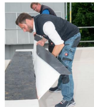
Sarnafil® AT-18 FSA P wurde am aufgehenden Bauteil angelegt, nach Abziehen des rückseitigen Liners auf den Untergrund angedrückt und mit einer Andrückrolle abgewalzt.
