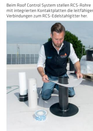
Beim Roof Control System stellen RCS-Rohre mit integrierten Kontaktplatten die leitfähigen Verbindungen zum RCS-Edelstahlgitter her.
