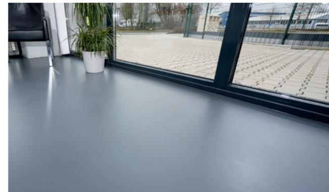
Die Böden in den Büro- und Sozialräumen erhielten eine Beschichtung mit dem Sika ComfortFloor® System PS-24. Auf die Grundierung Sikafloor®-161 wurde die Verlaufsbeschichtung Sikafloor®-3000 im Farbton RAL 7015 (Anthrakit) aufgebracht.
