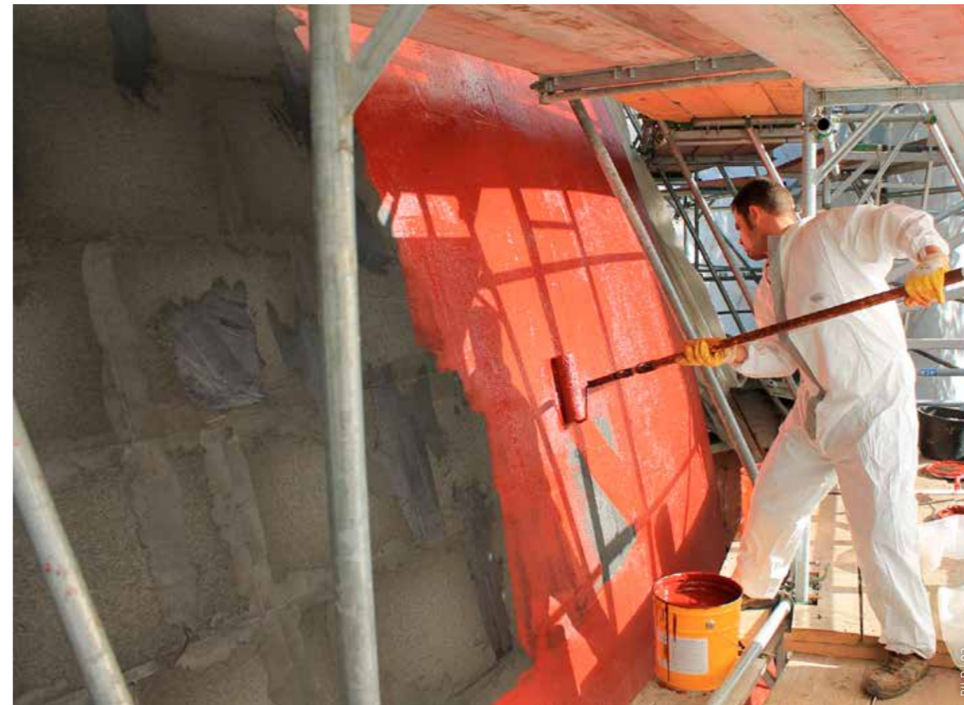
Das verwendete Sikalastic® Flüssigkunststoffsystem geht einen direkten Verbund mit der Wärmedämmung ein und passt sich über die Systemvlieseinlage frei an die Kuppelform an.
