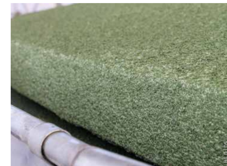
Die Sonderfarben der Flüssigabdichtung und des Schiefersplittes ermöglichten die Wiederherstellung der ursprünglichen Optik der Kuppel.
