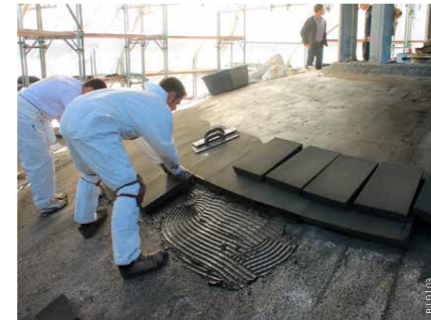
Die Dämmung des Neuaufbaus aus Schaumglas wurde direkt auf die Betonschale aufgeklebt.
