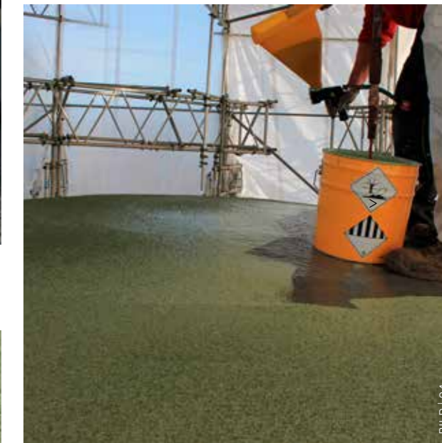
Die abschließende Schiefersplitt-Einstreuung wurde pneumatisch gleichmäßig aufgetragen.
