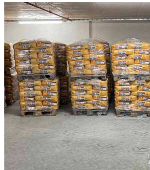
Die Citylage der Baustelle ließ nur eine Anlieferung der großen Materialmengen als Sackware zu. Diese wurde nur nach Notwendigkeit vorgehalten und in den Zwischenebenen gelagert.
