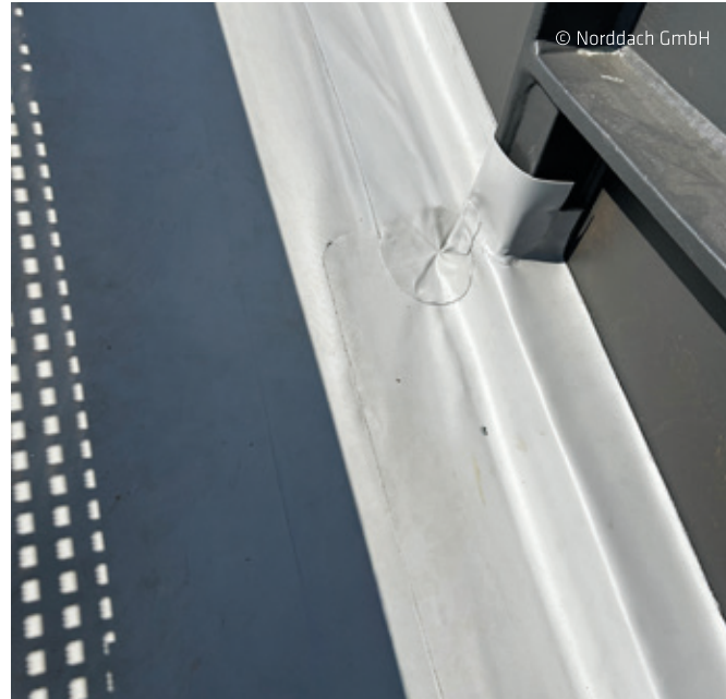
Verarbeitung der selbstklebenden FPO-Anschlussbahn Sarnafil® AT-18 FSA P an einer Durchdringung.
