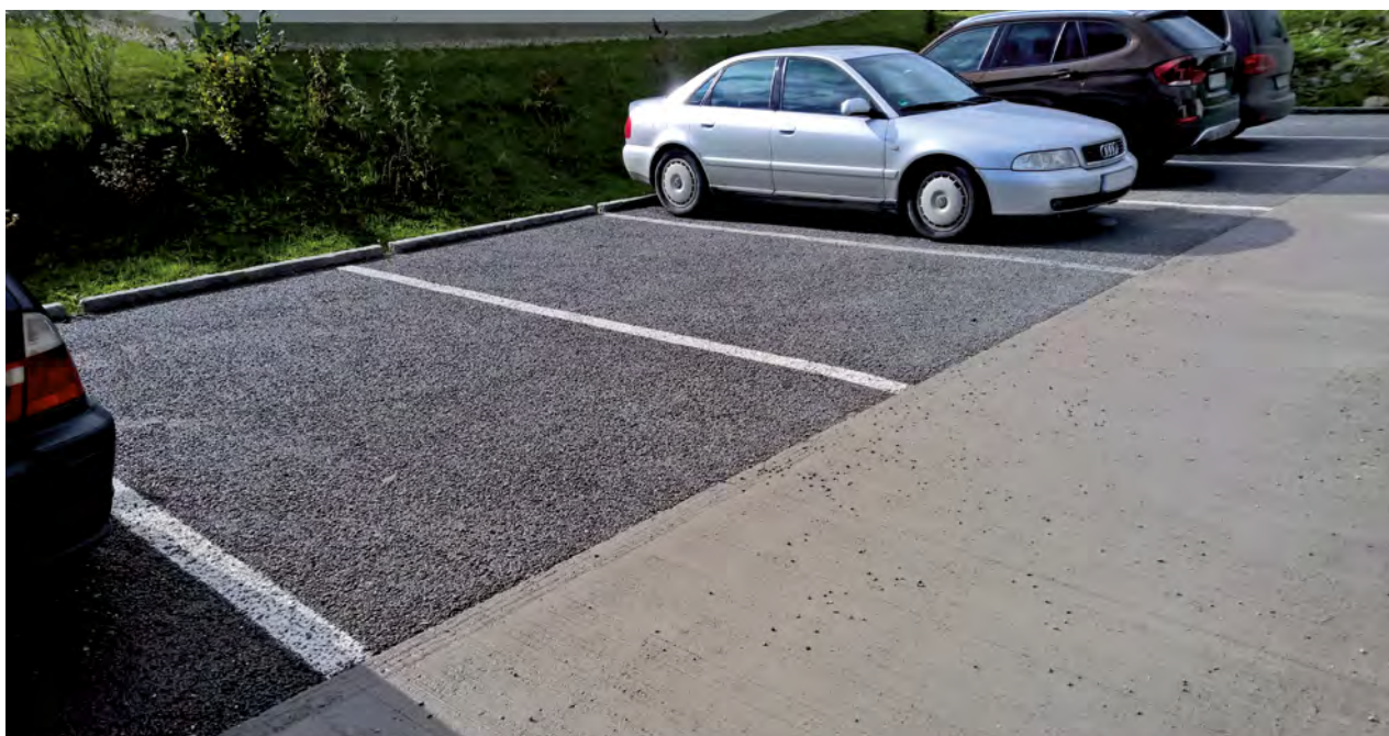
DRÄNBETONDECKSCHICHT, PARKPLATZ VOGLARN, © SIKA DEUTSCHLAND GMBH
