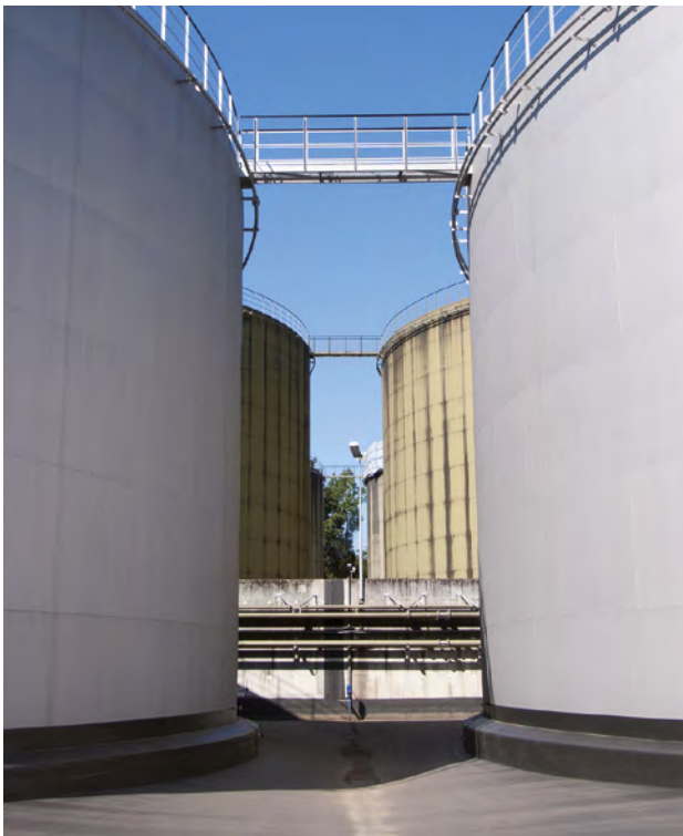
TANKLAGER OSTERWALDER, SENNWALD, SCHWEIZ. © SIKA DEUTSCHLAND GMBH
