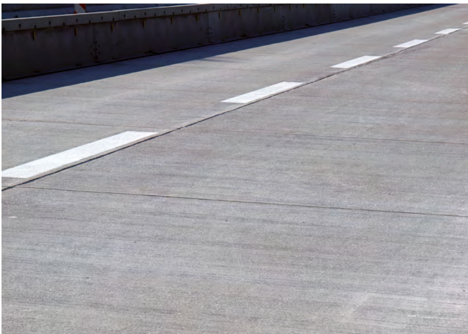
WHITETOPPING, BENSHEIM, © SIKA DEUTSCHLAND GMBH
