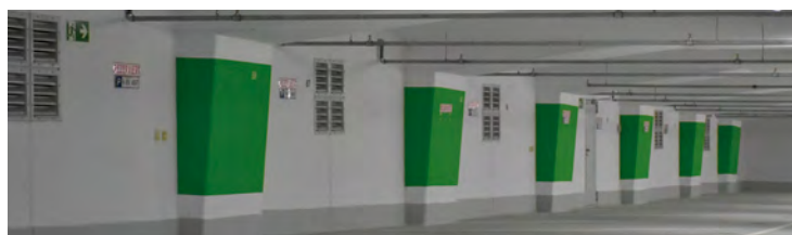
TIEFGARAGE, WEIDEN. © SIKA DEUTSCHLAND GMBH
