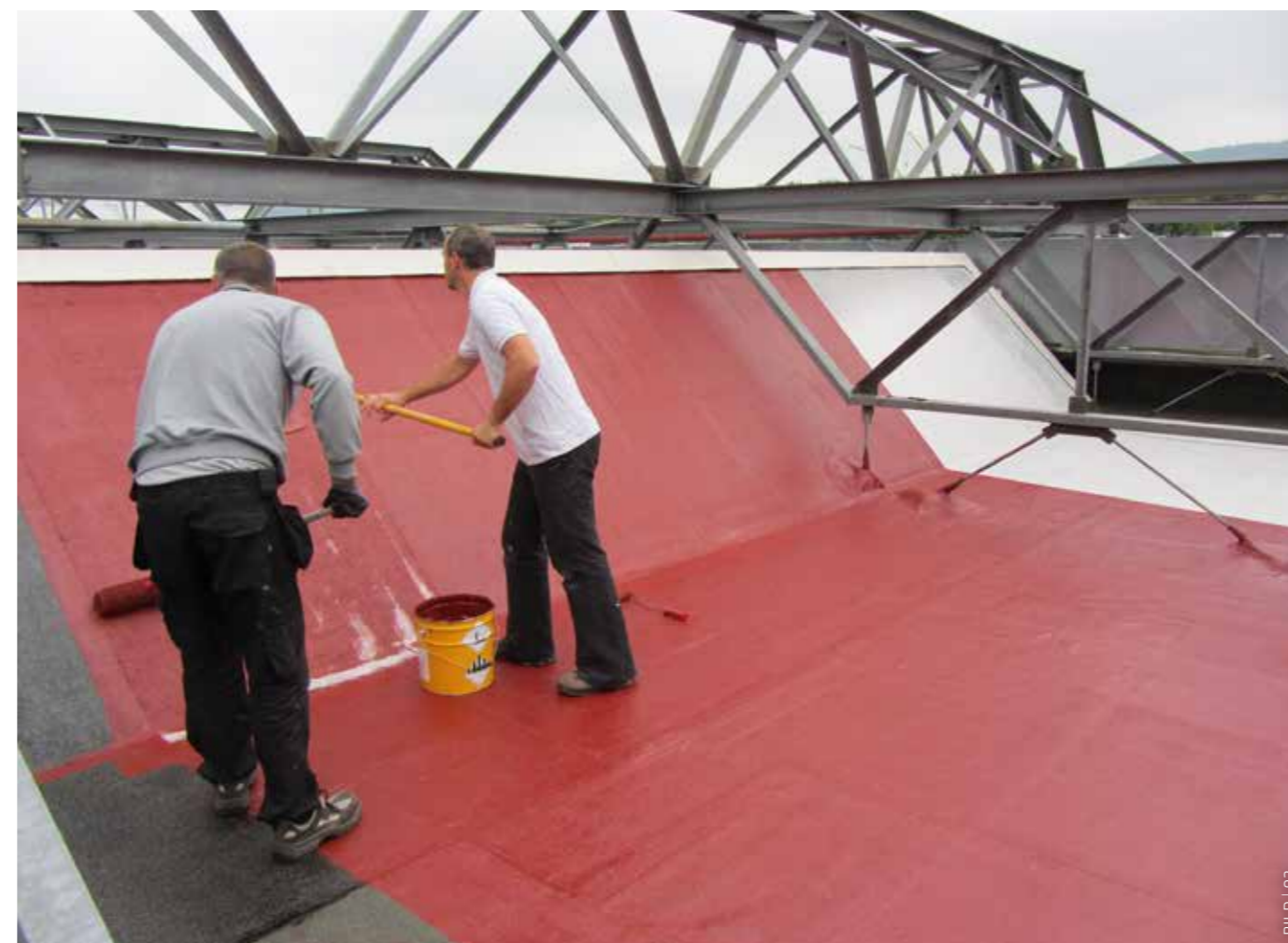
Die Systemvlieseinlage wird in die Sikalastic® Grundbeschichtung eingearbeitet.
