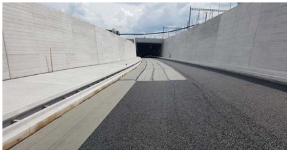
VERKEHRSBAUWERKE (Tunnel & Durchlässe)
