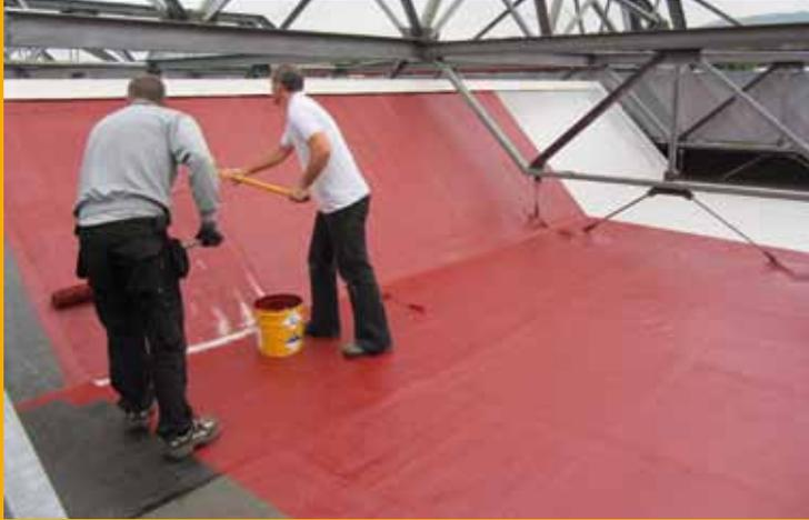
Die Systemvlieseinlage wird in die Grundbeschichtung Sikalastic®-601 BC eingearbeitet.
