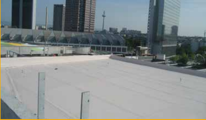
Auf dem Dach des Skyline Plaza wurde die FPO-Kunststoffdachabdichtung Sarnafil® TS 77-20 von Sika Deutschland verlegt.
