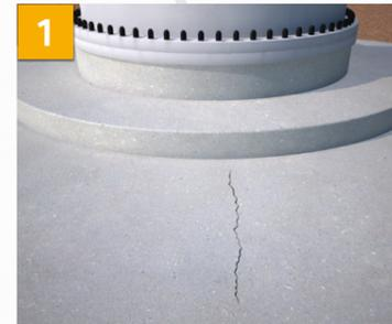
1 Beurteilen und reinigen Sie den Riss.
