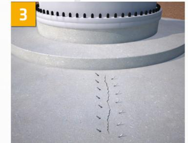
3 Setzen Sie die Injektionspacker ein.
