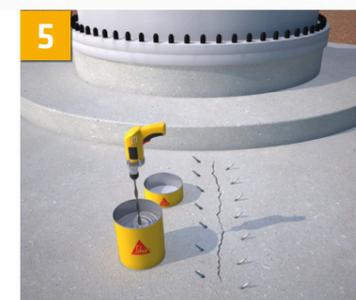
5 Mischen Sie die Komponenten mit einem langsamen Rührwerk.
