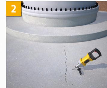
2 Bemessen Sie das Raster und bohren Sie Löcher für die Injektionspacker.
