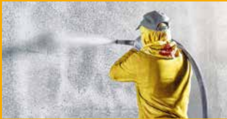
BETONSCHUTZ UND INSTANDHALTUNG
