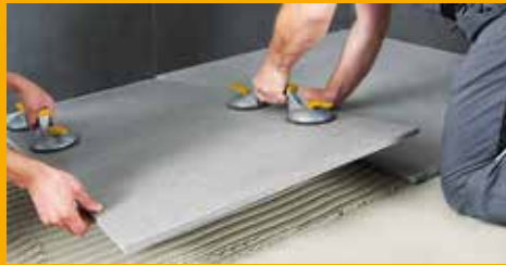
FLIESEN-, WAND- UND FUSSBODENTECHNIK
