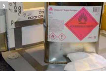
5 Schleifstaub entfernen / Oberflächen aktivieren z. B. Sikalastic® Rapid Reiniger.
