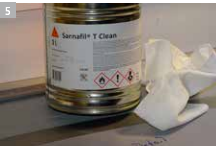
5 Schleifstaub entfernen/Oberflächen aktivieren z. B. Sarnafil® T-Clean oder Sikalastic® Rapid Reiniger.
