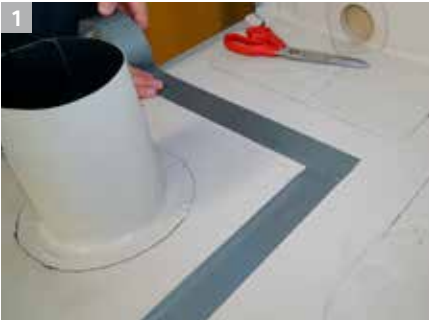
1 Abzudichtenden Bereich mit Klebeband abgrenzen.
