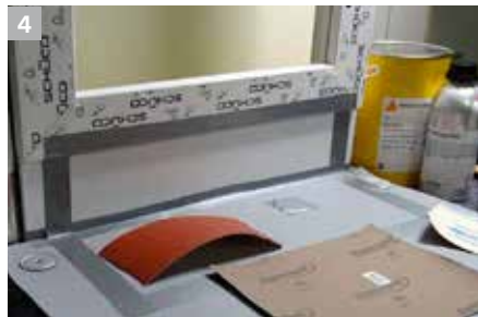
4 Untergrundvorbereitung durch bauseits geeignete Maßnahmen. Bsp. Hart PVC anschleifen mit Schleifpapier K80 bis K120. Wichtig ist ein gleichmäßiges Schleifbild.
