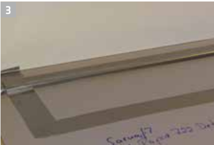
3 Abzudichtende Bahn mit Klebeband abgrenzen, Sarnabar®-Schiene mit Klebeband PE Oberfläche entkoppeln.
