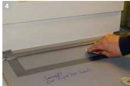
4 Untergründe vorbereiten: - z.B. Hart PVC anschleifen mit Schleifpapier K80 bis K120 - z. B. Sarnafil® FPO PP anschleifen mit Schleifpapier K60. Wichtig ist ein gleichmäßiges Schleifbild.
