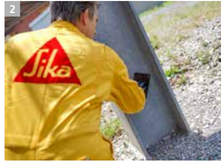
2 Untergrundvorbereitung durch bauseits geeignete Maßnahmen. Grundierung gemäß Grundierungstabelle Sikalastic®-641.
