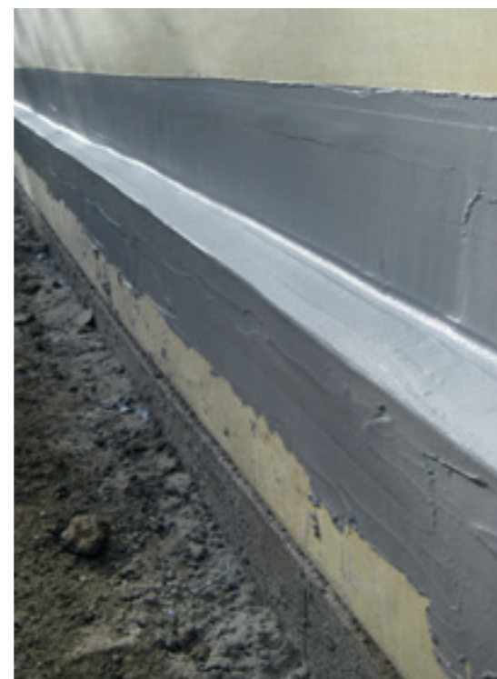
Übergänge als Detaillösung: Sikadur-Combiflex® TF System auf SikaProof® Gesamtsystem
