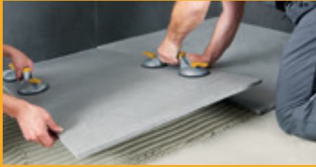
FLIESEN-, WAND- UND FUSSBODENTECHNIK
