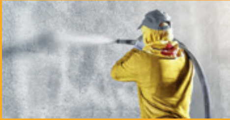
BETONSCHUTZ UND INSTANDHALTUNG
