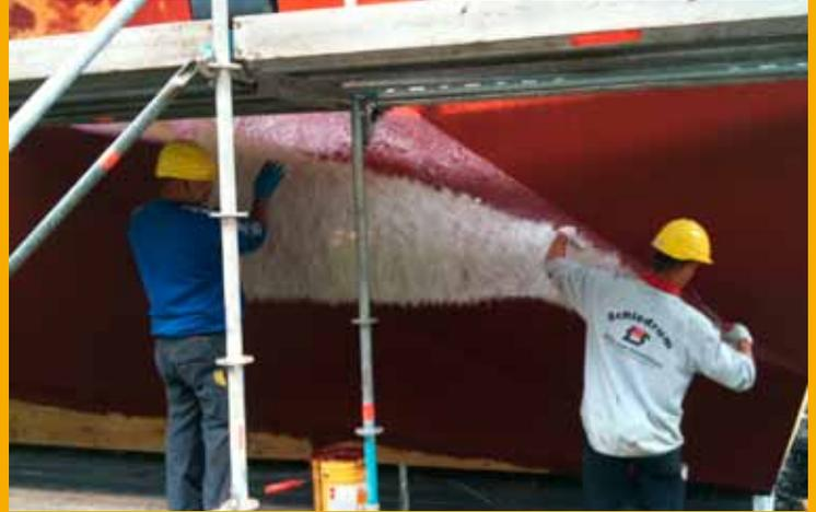
Dank des Sikalastic® Flüssigabdichtungssystems SikaRoof® MTC ist es nun auch von allen Seiten sicher abgedichtet.
