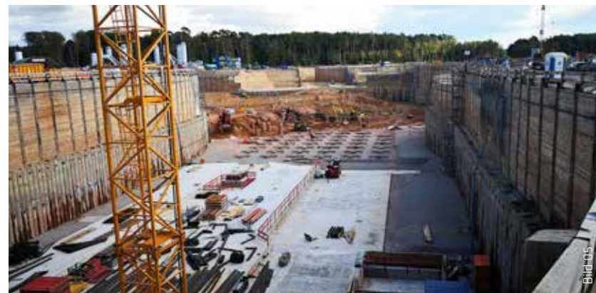
Bereits lange vor der Ausführung der Bohrpfahlkopfausbildungen (Bildmitte, noch ohne Abdichtung) und der Versprünge (Bildmitte, vorn, bereits abgedichtet) wurde alles im Detail geplant.
