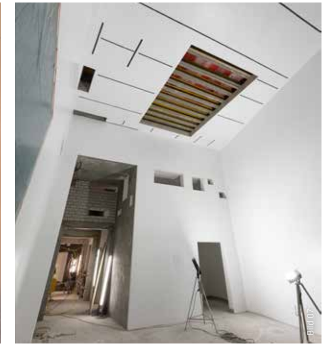
Für die Wände wurde der kunststoffmodifizierte Feinspachtel Sika® MonoTop-723 ebenfalls in Kombination mit der dekontaminierbaren Beschichtung Sikagard® WallCoat N verwendet.
