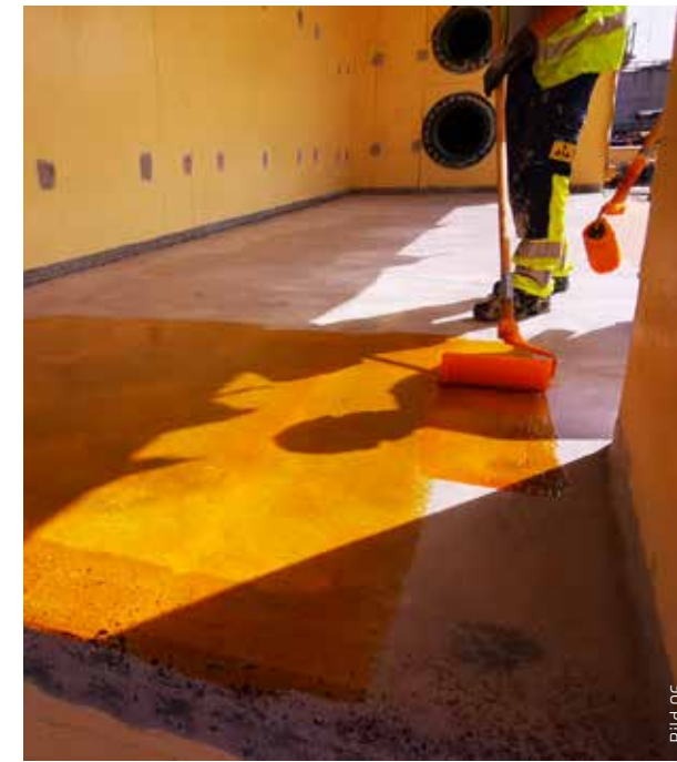
Vorbehandlung des Untergrunds für die Verlegung von SikaProof® P-12 mit dem speziellen Haftvermittler SikaProof® Primer-01.
