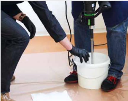
Manuelles Mischen von 2-komponentigem Sikasil® GS-687 mit einem Konusrührer
