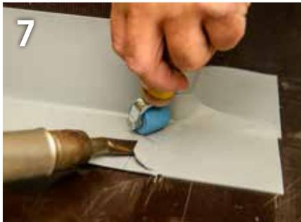
Verschweißen Sie abschließend alle Nahtverbindungen des Passtückes vollständig und fest mit dem angrenzenden Dichtstreifen.
