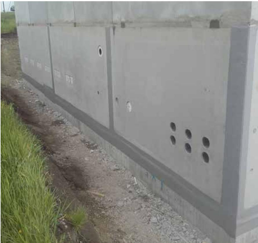
Abklebung von Arbeitsfugen am Beispiel eines Fertigteilkellers
