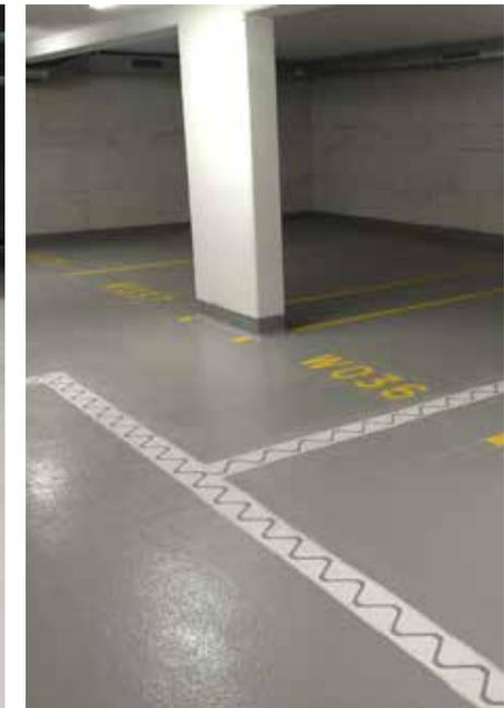
Überfahrbare Dehnfugenabdichtung mit einem Sika® FloorJoint Überfahrprofil mit Sinusverlauf
