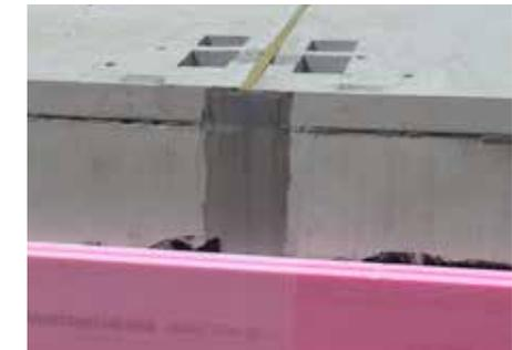
Anfüllschutz der Dehnfugenablhebung durch Perimeterdämmung
