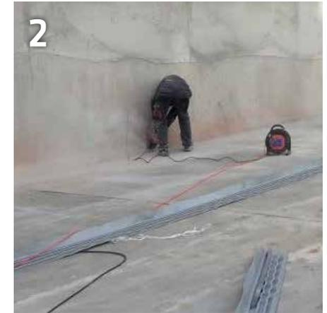
Untergrundvorbereitung durch Anschleifen der späteren Klebefläche
