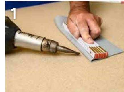
1 Formen Sie den Dichtstreifen längs im Winkel thermisch um.
