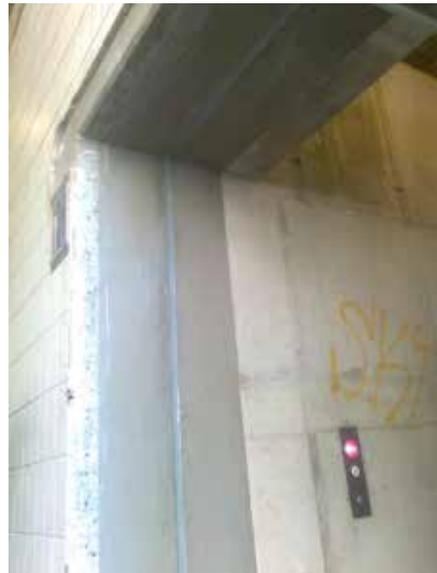
Sanierung einer Dehnfuge – hier ist abschließend eine Unterstützungskonstruktion durch eine Schleppblechverwahrung anzuordnen.
