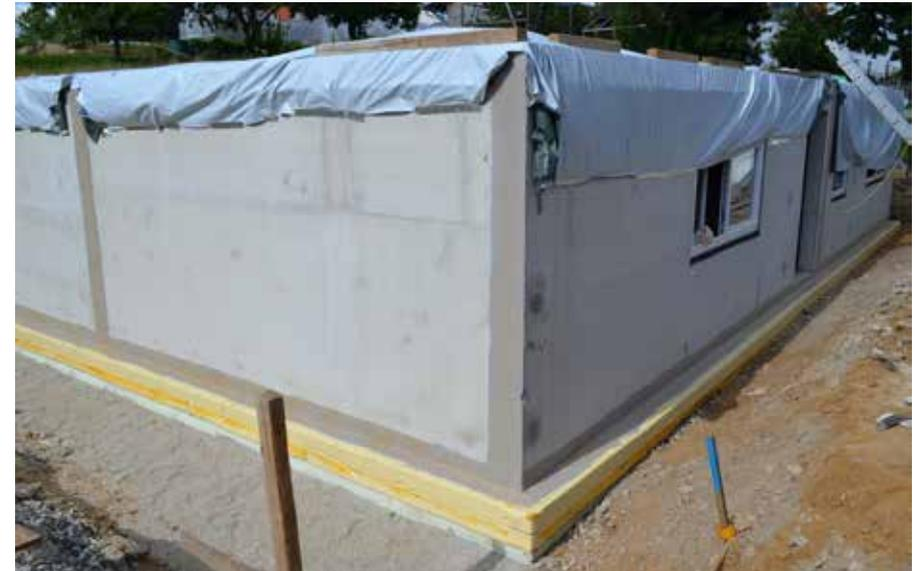
Kombination von Sikadur-Combiflex® TF System mit dem SikaProof® Frischbetonverbundsystem in der Bodenplatte
