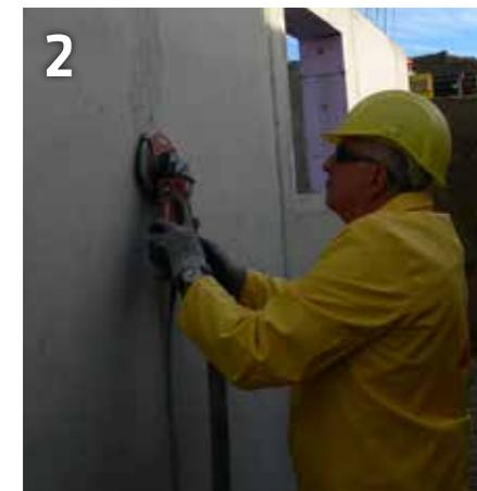
Untergrundvorbereitung durch Anschleifen mit Topfscheibe
