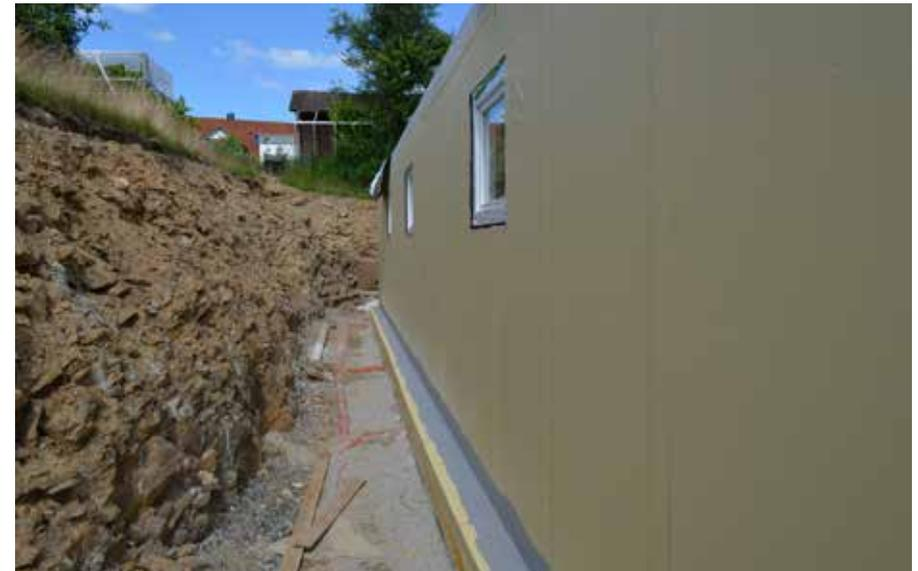
Kombination von Sikadur-Combiflex® TF System mit dem SikaProof® Frischbetonverbundsystem in Bodenplatte und Wand
