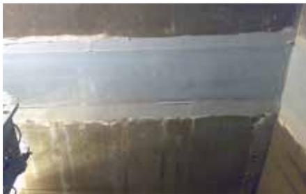
Sanierung einer undichten Arbeitsfuge
