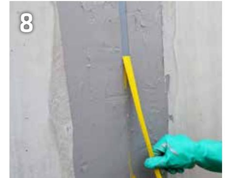
Klebebänder anschließend abziehen (innerhalb der Verarbeitungszeit des Systemklebers)
