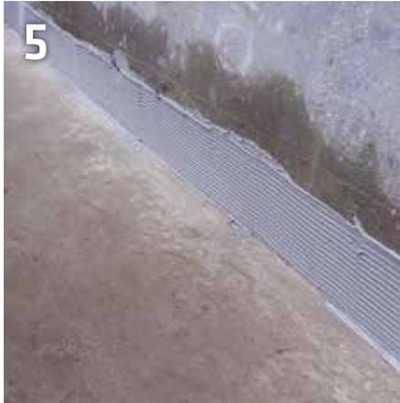
5 Grundauftrag des Systemklebers für die Verklebung eines DFT-Fugenbandprofils
