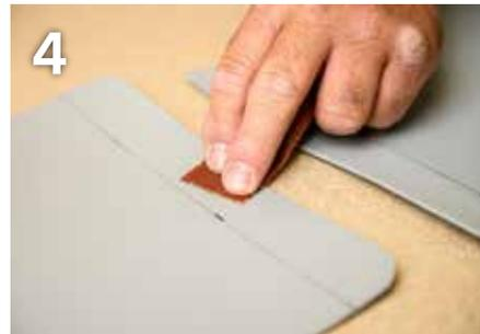
4 Überlappungsbereich oberflächlich mit Scotch Brite oder Sandpapier leicht anschleifen.
