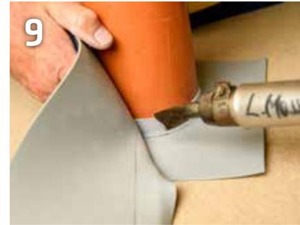
9 Führen Sie eine Punktschweißung des Hülsenstücks im Überlappungsbereich auf dem Unterteil rund um das Rohr durch. Anschließend wird das Hülsenstück selbst durch Punktschweißung geheftet. Achten Sie beim Platzieren darauf, dass die Hülse nicht zu eng am Rohr sitzt. Sie sollte ein leichtes Spiel haben, damit später der Systemkleber nicht vollständig verdrängt wird.
