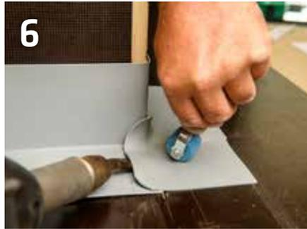
Setzen Sie das Passtück in seine Position und befestigen Sie es im Eckbereich durch eine Punktschweißung. Anschließend verschweißen den ersten Zentimeter der Überlappung.
