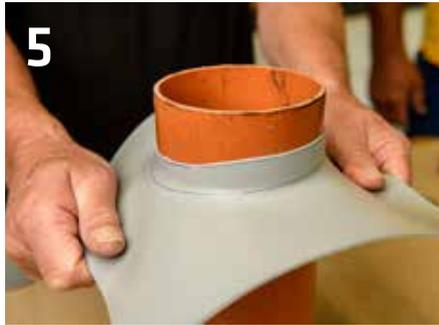
5 Ziehen Sie das Manschettenstück vollständig bis zum Betonuntergrund bis es bündig auf dem Boden sitzt.
