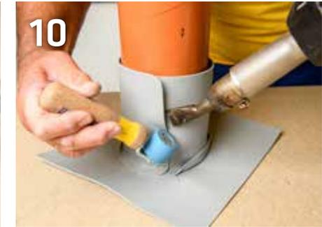
10 Vertikale Naht des Hülsenstücks vollständig verschweißen.
