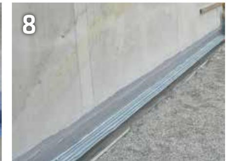
8 Fertig appliziertes DFT-Fugenbandprofil
