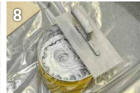
8 Weitere 1 Minute rühren und kontrollieren, dass die Masse vollständig schlierenfrei ist. Danach ist der Kleber gebrauchsfertig und sollte schnellstmöglich verarbeitet werden.
