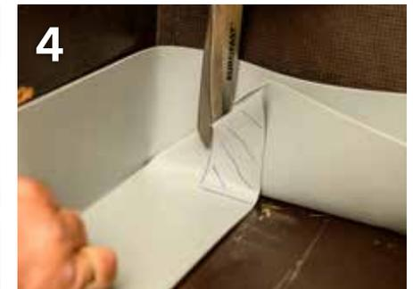
4 Schneiden Sie den angezeichneten Teil der Falte mit einer Schere heraus, mindestens 50 mm in der Ecke (wie auf dem Bild zu sehen) müssen bestehen bleiben.
