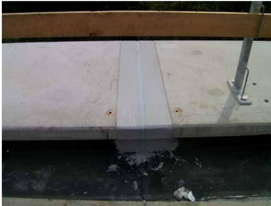
Die Ausbildung kann zur Abdichtung auf Brückenbauwerken eingesetzt werden und entspricht den Vorgaben der BAST-Richtzeichnung FUG 4 Blatt 2.
