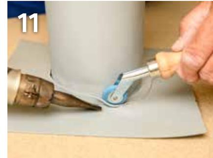
11 Untere Naht zum Manschettenstück vollständig verschweißen.
