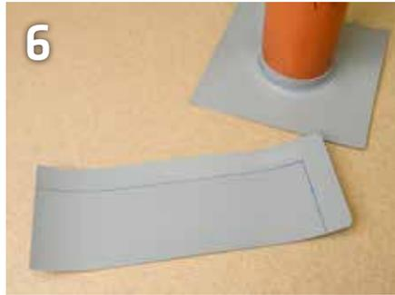
6 Fügen Sie nun im weiteren Schritt das Hülsenstück hinzu. Schneiden Sie dazu ein rechteckiges Stück vom Dichtstreifen zurecht, das je nach Rohrumfang dimensioniert ist.
