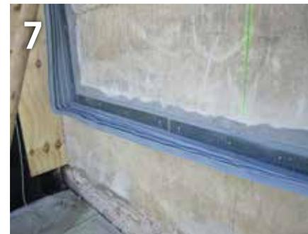
7 Fixieren des DFT-Fugenbandprofils mit einer Lochblechschiene
