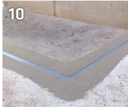
Abgesandetes Kleberbett zur späteren Aufnahme anzuschließender Beschichtungen
