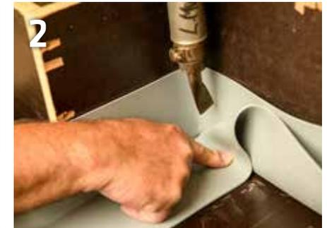
2 Legen Sie den Dichtstreifen in die Ecke und falten Sie das überschüssige Material nach oben. Anschließend die Falte kurz thermisch Formen, damit sie passgenau liegt.
