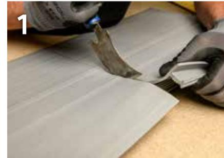
Die Profile auf benötigte Länge abmessen und winkeltreu zuschneiden. Je Fugenbandende sind ca. 5 mm Schmelzverlust zuzugeben.
