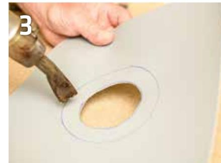
Erwärmen Sie das das vorbereitete Manschettenteil im markierten Überlappungsbereich. Gehen Sie vorsichtig und schrittweise vor, damit Sie den Dichtstreifen nicht beschädigen.
