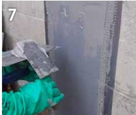
Deckauftrag des Systemklebers bei einer Arbeitsfuge
