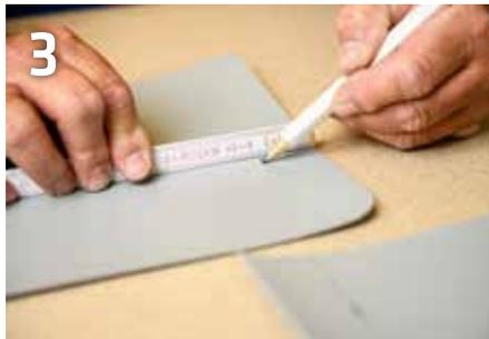
3 Überlappungsbereich anzeichnen. Die Dichtstreifen werden mit einer Überlappung von 3-4 cm verschweißt.
