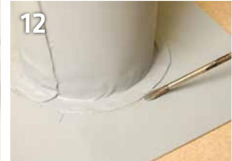
12 Überprüfen Sie abschließend die abgekühlten Schweißnähte sorgfältig mit einem Schlitzschraubendreher.
