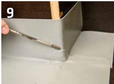
Überprüfen Sie die abgekühlten Schweißnähte sorgfältig mit einem Schlitzschraubendreher auf beiden Seiten.
