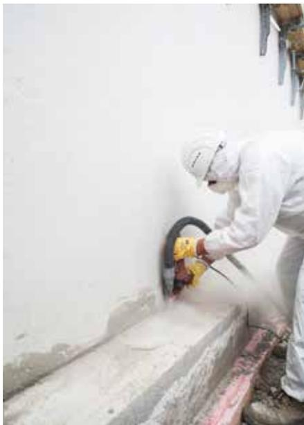
Untergrundvorbereitung durch Anschleifen der Betonflächen
