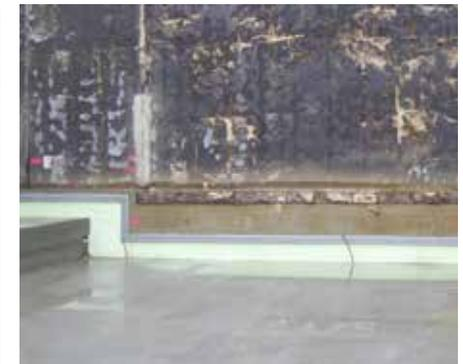
Abdichtung einer Anschlussfuge an ein Bestandsbauwerk mittels FAT130/3 KF Profil
