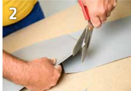
2 Am überlappenden Dichtstreifen die Ecken mit einer Schere abrunden.
