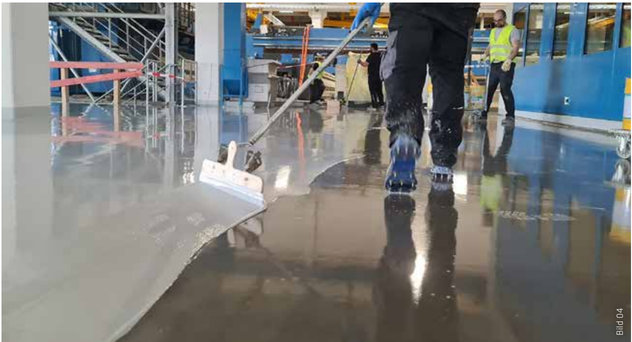
Die Verlaufsbeschichtung Sikafloor® 264 N wird mit dem Gummischieber verteilt.
