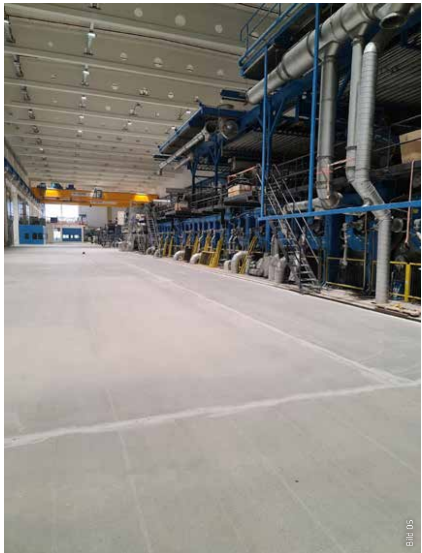
Die Halle der neuen Papierfabrik Palm. Die Nutzflächen werden mit Sikafloor® MultiDur EB-26 N beschichtet, die Auffangtassen für wassergefährdende Stoffe mit dem Sikafloor® Gewässerschutz-System 390 N Plus.
