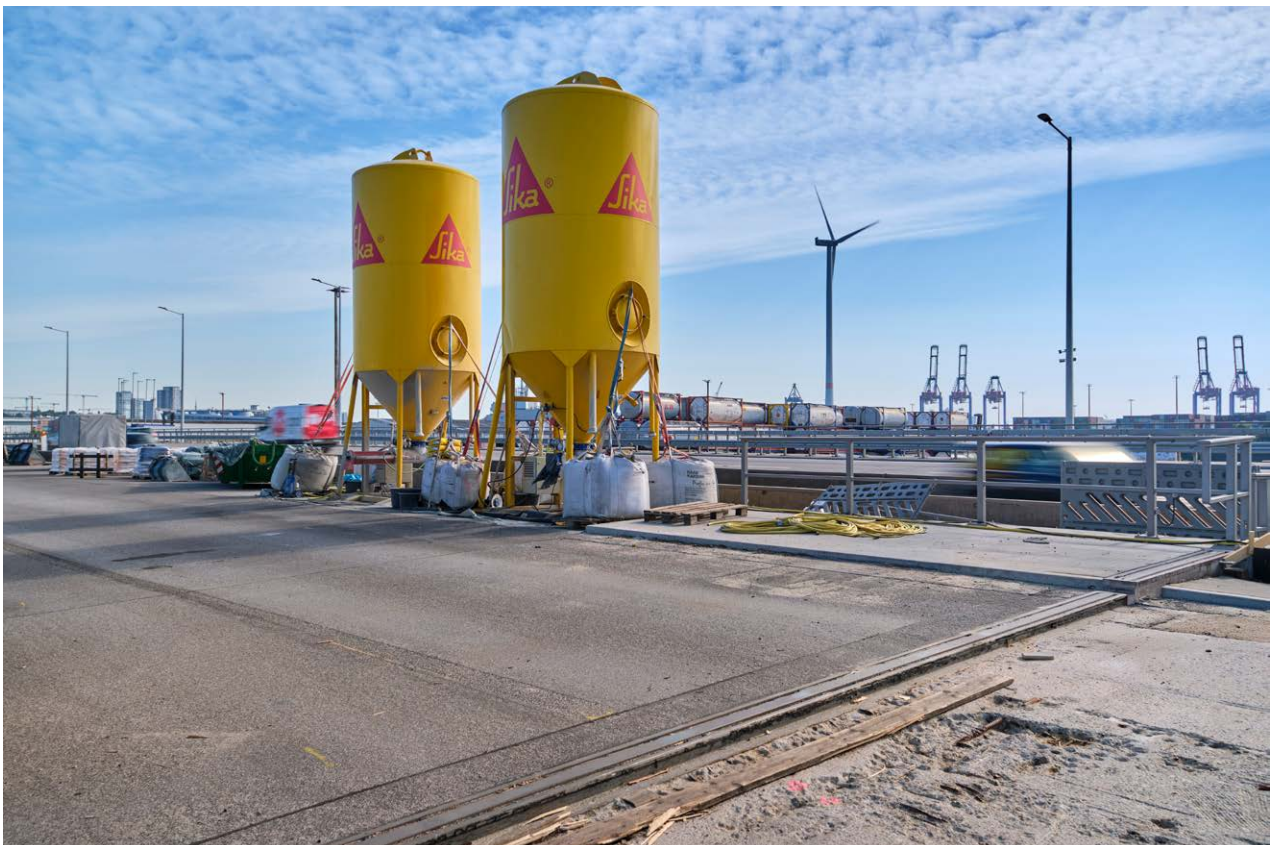
Die Silo-Technologie unterstützt die Aufbewahrung, Dosierung und Mischung großer Materialmengen an einem Ort
