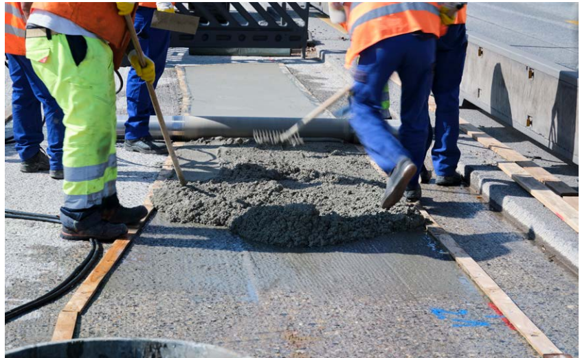
Reprofilierarbeiten mit Sika BE®-08
