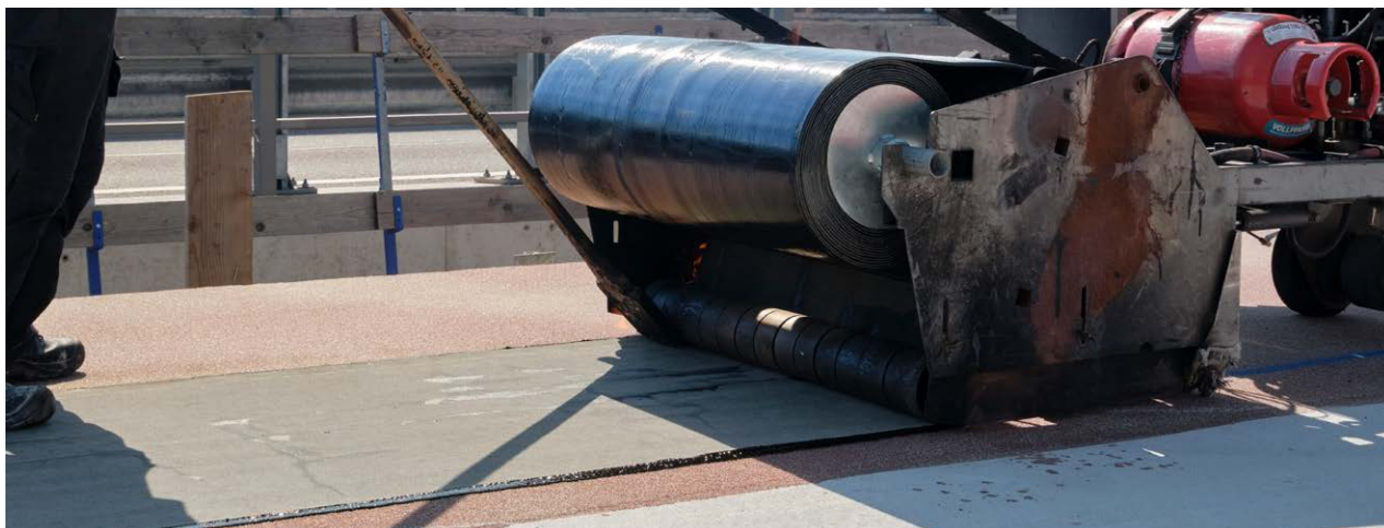
Verschweißung des SikaShield Ergobit® Pro mit einer Verlegemaschine
