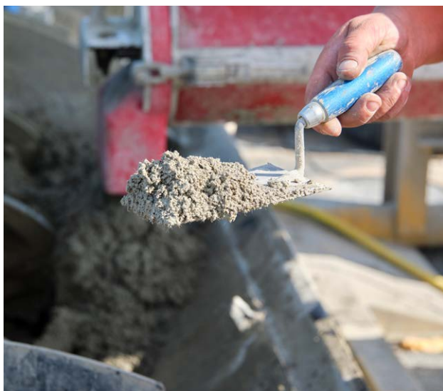
Qualitätsüberwachung des Sika BM®-04 auf der Baustelle
