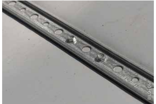
Die lineare, mechanische Befestigung der Abdichtungsbahn ermöglicht eine Reduzierung der Befestigungspunkte.
