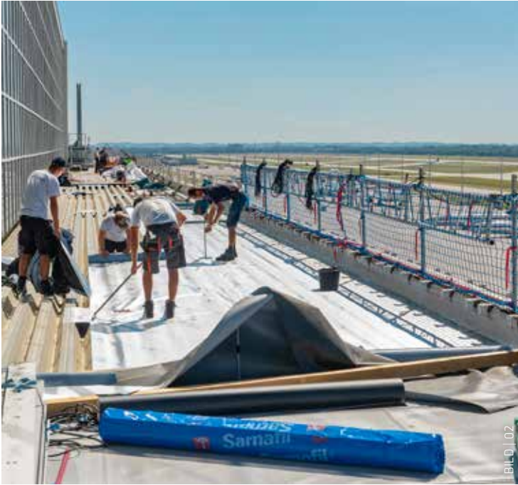
Als erste Lage wird auf dem Stahltrapez die Dampfsperre Sarnavap 5000 E SA FR verlegt
