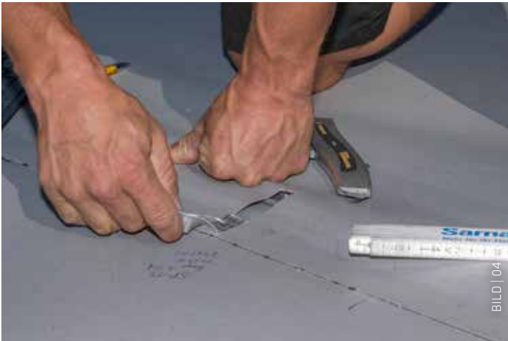
Schälproben an der Nahtstelle sorgen für eine hohe Qualitätssicherung bei der Sanierung des Hallendachs und bestätigen die ordnungsgemäße Verschweißung.
