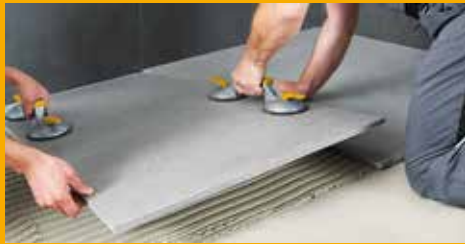
FLIESEN-, WAND- UND FUSSBODENTECHNIK
