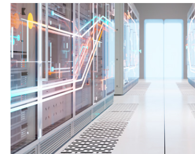
Data Center | Serverräume
