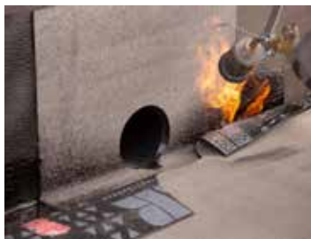
Flächiges Aufschweißen der 1. Lage Flächenabdichtung
