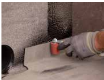
Mit der Silikonrolle wird ein kontrollier- ter Bitumenaustritt hergestellt
