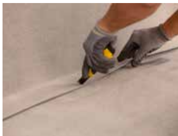
Anpassen der 1. Lage Hochzugsabdichtung
