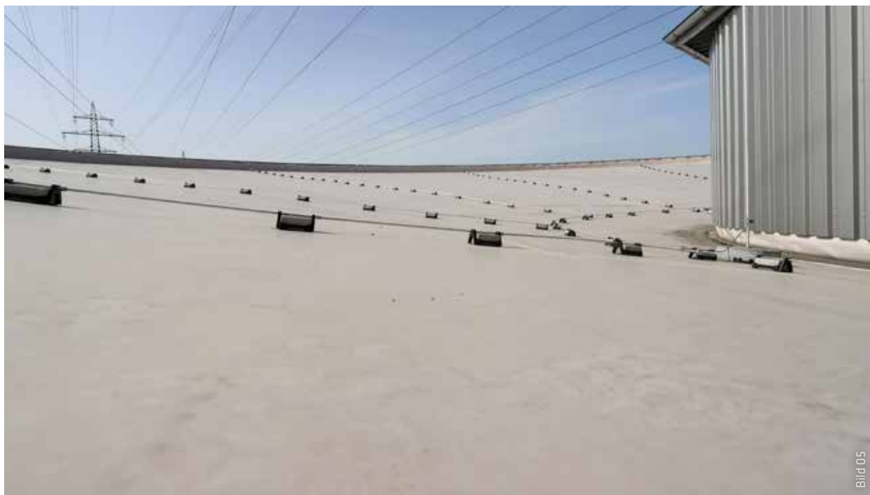
Auf dem Kegelschalendach wurde aus optischen Gründen die Abdichtungsbahn Sarnafil® 76-18 FSA in Grau verlegt. Das Dach wird von einer 4 mm dicken Blechmembran getragen, die auf Zug vorgespannt war.
