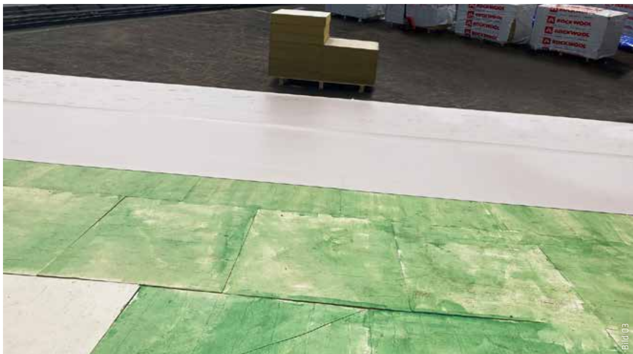
Die verschiedenen Schichten auf dem Dach: Die Stahlmembran (schwarz), die mit dem Primer versehene Wärmedämmung (grün) und die Abdichtungsbahn Sarnafil® TG 76-18 FSA in Grau.
