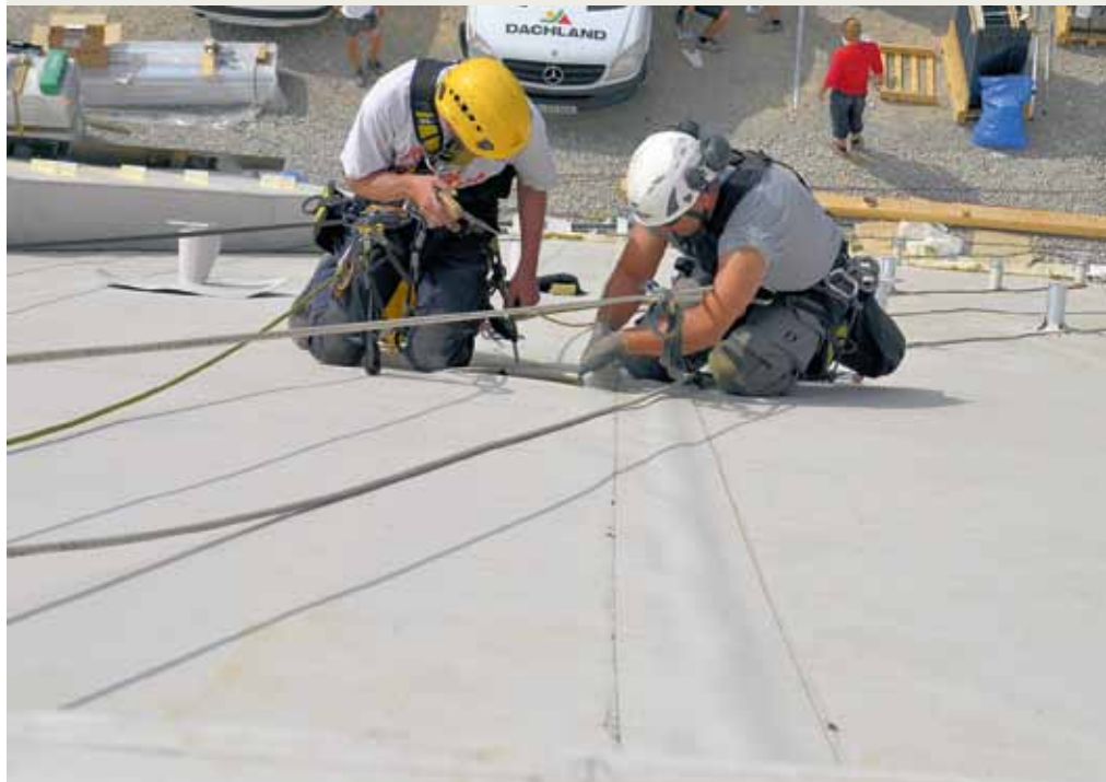
Die PV-Halterungen (170 Stück) für die riesige PV-Anlage mit einem jährlichen Stromertrag von 88.000 kWh wurden nachträglich in die Fläche eingearbeitet.
