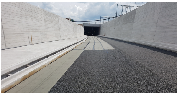
VERKEHRSBAUWERKE (Tunnel & Durchlässe)
