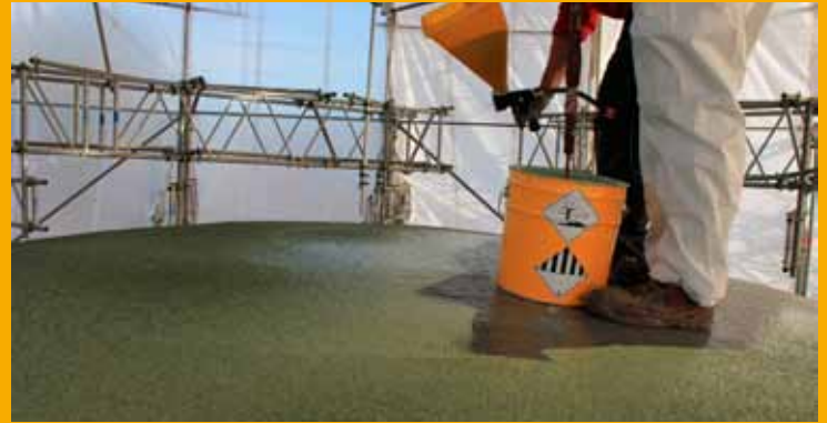
Die abschließende Schiefersplitt-Einstreuung wurde pneumatisch gleichmäßig aufgetragen. Die Sonderfarben der Flüssigabdichtung und des Schiefersplittes ermöglichten die Wiederherstellung der ursprünglichen Optik der Kuppel.
