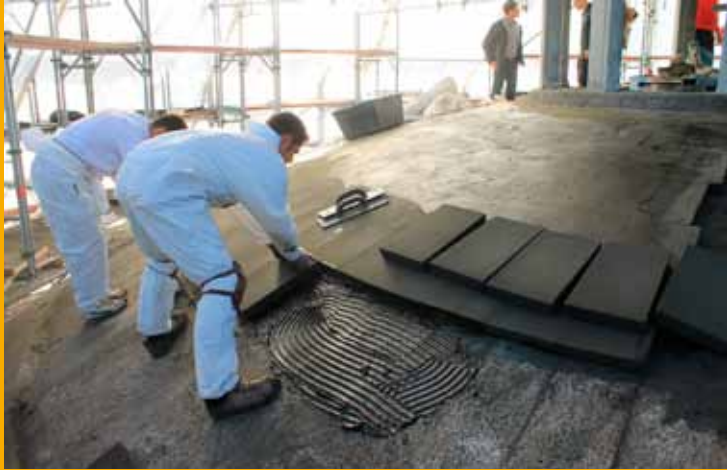
Die Dämmung des Neuaufbaus aus Schaumglas wurde direkt auf die Betonschale aufgeklebt.
