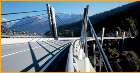
BETONSCHUTZ UND -INSTANDSETZUNG
