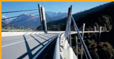
BETONSCHUTZ UND -INSTANDSETZUNG
