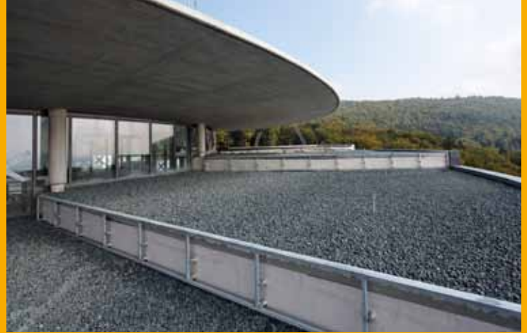
Gut zu erkennen sind die getreppten Dachflächen, abgedichtet mit Sarnafil® TG 66-20, mit Kiesauflast gesichert.
