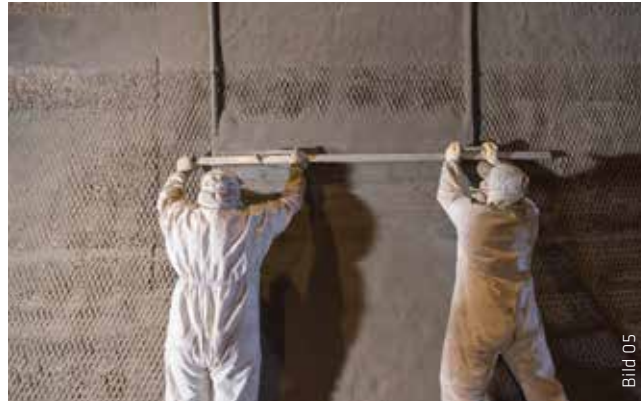
Der SPCC-Mörtel SikaCem® Gunit-212 SF wird händisch mit einer Alulatte auf Stahlrohrlehren abgezogen. Die Applikation erfolgte im Pilgerschritt-Verfahren.
