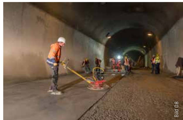
Die Reprofilierung der Tunnelsohle wurde mit dem PCC I-Betonersatz-System SikaTop® ES-104/-108 ausgeführt.
