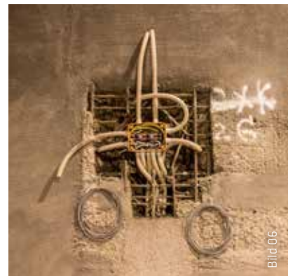
Die elektrische Verkabelung der Stahlbewehrung für den Kathodischen Korrosionsschutz im Kanaltunnel Rendsburg.
