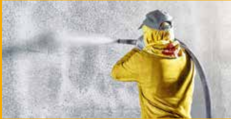
BETONSCHUTZ UND INSTANDHALTUNG
