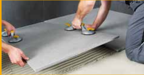
FLIESEN-, WAND- UND FUSSBODENTECHNIK
