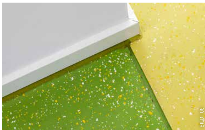
Bei geringen Arbeitsbreiten werden die Sikafloor® Colorchips von Hand auf die Beschichtung eingestreut. Eine gleichmäßige Arbeitsweise und ein geschultes Auge garantieren eine einheitliche Anmutung der Oberfläche.
