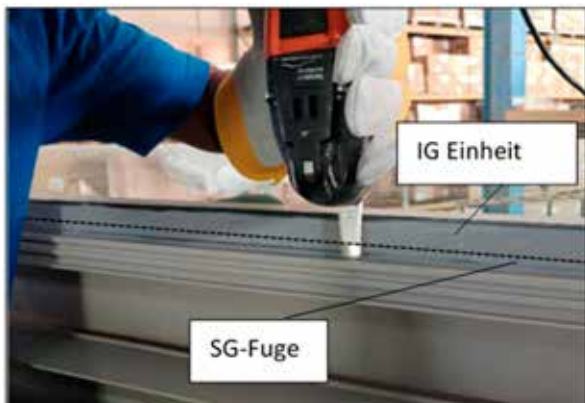
Abbildung 35: Die Fuge in der Mitte über die gesamte Länge des verklebten Elementes einschneiden (grauer SG-Silikon im Bild)
