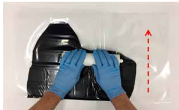
Abbildung 6: Raupe senkrecht zum Falz verpressen
