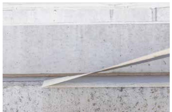
Die durchschnittliche Fugenbreite betrug +/- 20 mm. Bei überdimensionierten Fugen um 50 mm Breite waren handwerkliches Geschick und Routine erforderlich.
