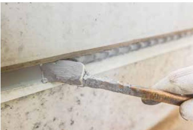
Das Abglätten der mit Sikaflex® PRO-3 bzw. Sikaflex® PRO-3 Purform abgedichteten Fugen erfolgte mit Hilfe eines Gummispachtels.
