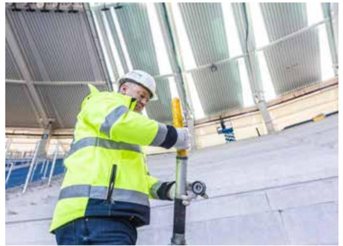
Der Fugendichtstoff wurde auf einer Gesamtlänge von 52 km verarbeitet. Ein Schlauchbeutel reicht für 2,5 bis 3 Meter.
