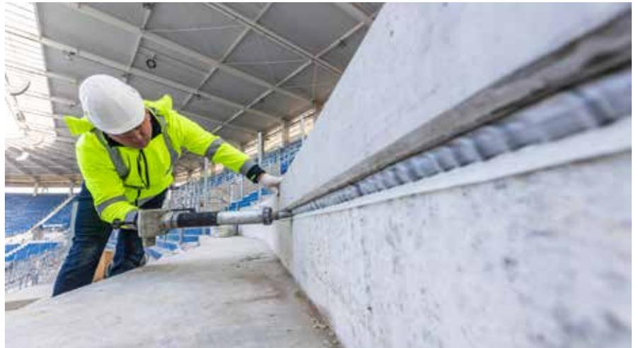
Der Fugendichtstoff Sikaflex® PRO-3 bzw. Sikaflex® PRO-3 Purform wurde mit akkubetriebenen Verarbeitungsgeräten eingebracht.
