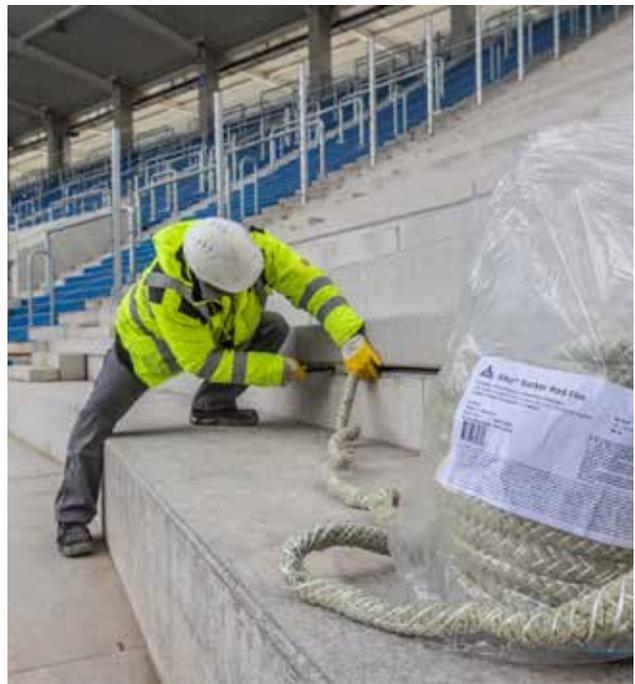
Die Brandschutzschnur aus Steinwolle wurde auf insgesamt 10 km Länge mit einem stumpfen Werkzeug in die vorbereitete Fuge eingebracht.
